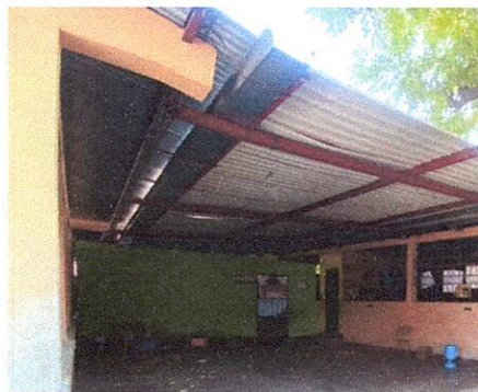
Foto 14: Sustitución de canal de metal deteriorado por canal de metal, Instalación de bajada de agua pluvial en el corredor
