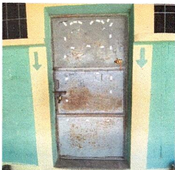
Foto 13: Mantenimiento a estructura de puerta de metal de 2.07x1.00 mts en aula 5
