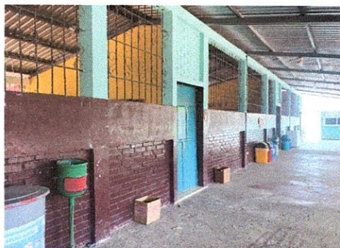
Foto 16: Pintura en muro exterior de las aulas 6,7,8 y 9
