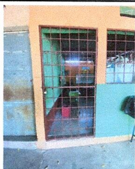
Foto 3: Sustitución de puerta de metal de rejas de 2.10x0.96 mts por puerta de metal sellada de 2.10x0.96 mts en aula 1
