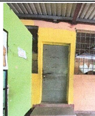
Foto 2: Mantenimiento a estructura de puerta de metal de 0.96x2.10 mts (cepillado, pintura, desinstalar e instalar) en aula 3
