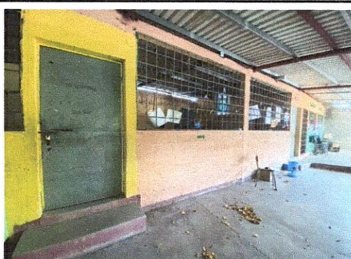
Foto 8: pintura en muros exteriores en aula 1,2 y 3
