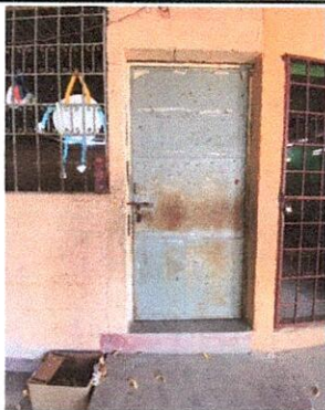
Foto1: Mantenimiento a estructura de puerta de metal de 0.96x2.10 mts (cepillado, pintura, desinstalar e instalar) en aula 2
