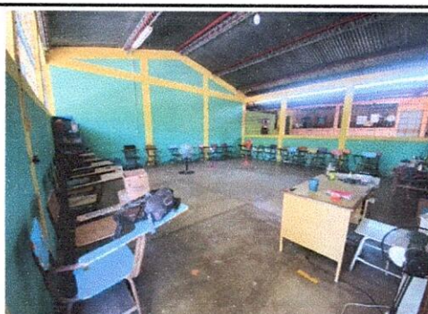
Foto 10: Sustitución de interruptores simples, Sustitución de tomacorrientes dobles, Instalación de ventilador de techo, pintura en muro interior en aula 4
