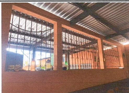
Foto 9: Instalación de ventana de pvc con vidrio transparente de 2.29x1.39 mts con su cedazo en aula 1
