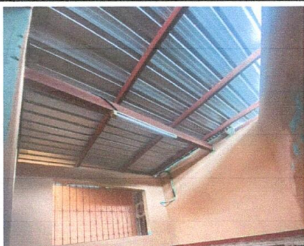
Foto 3: Sustitución de lampara por lampara led empotrables, instalación de ventilador de techo, instalación de cielo falso vinilico, reparación de pared sellando el espacio que hay entre pared y lamina en la cocina
