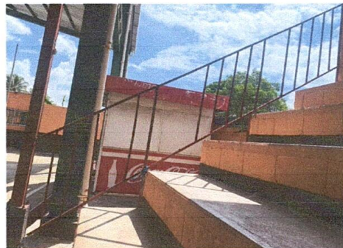
Foto 8: Sustitución de barandas de metal deterioradas por barandas de metal de 1.00x4.45 mts en el graderío
