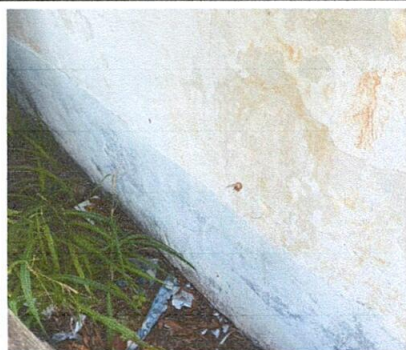
Foto 11: Reparación de repello en pared exterior del aula 2
