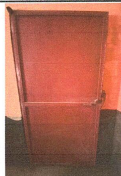
Foto 6: Mantenimiento a estructura de puerta de metal de 0.99x2.10 mts en la cocina
