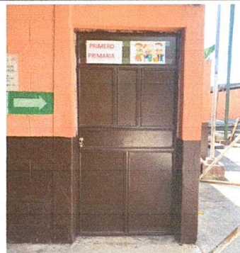
Foto 14: Mantenimiento a estructura de puerta de metal de 1.00x2.10 mts, sustituir chapa en aula 7
