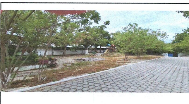
Foto 4: Instalación de Lámparas Solares, se fundirá una base con concreto en el cual se soportará un tubo metálico para la elevación de lámparas solares.
