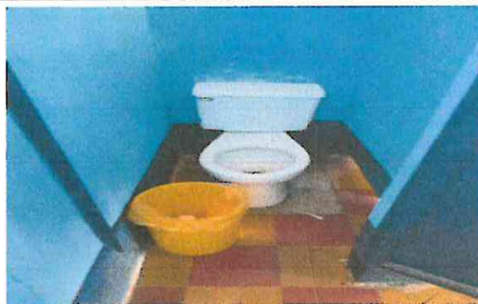
Foto 6: Sustitución de Inodoros
