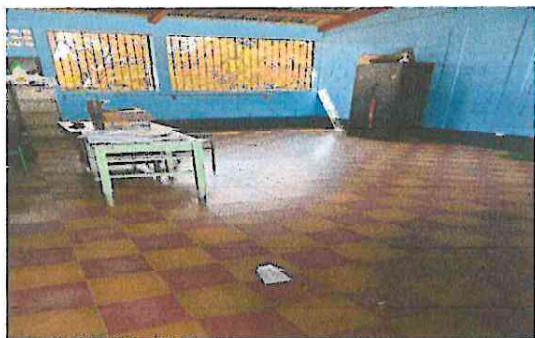
Foto1: Sustitución de Piso de Granito por Piso Cerámico Mate PAE 4
