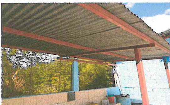
Foto 5: Sustitución de Lámina por Lámina Troquelada y Mantenimiento de Estructura en Galera de Patio (Se Instalará un Tendam para Reforzar la Estructura de Soporte)
