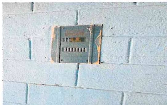
Foto 4: Sustitución de Caja de Registro de Dos Flípones en Aulas
