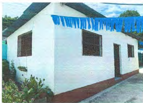
Foto 5: Mantenimiento a balcones de metal de 1.04x1.49 mts (lijado y pintura), Instalación de ventanas de pvc con vidrio transparente de 1.04x1.49 mts y su cedazo en aula de computación
