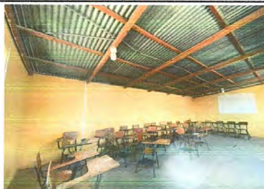
Foto 4: Reparación de Muro de block del aula pegando 2 hiladas de block para elevar el techo con repello, cernido, continuar columnas en aula de computación
