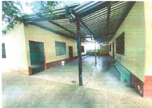
Foto 7: Instalación de canal de metal incluye mano de obra y soportes de metal (ya hay material), Instalación de bajada de agua pluvial en el corredor
