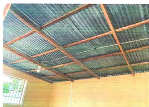
Foto 3: Sustitución de estructura de soporte de madera por metal en el techo, sustitución de lamina por lamina troquelada aluzinc calibre 26, Instalación de cielo falso vinilico en aula de computación
