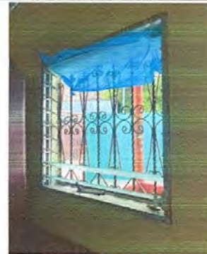
Foto 12: Sustitución de ventana de persiana por ventana de pvc con vidrio transparente de .084x0.84 Mts y su cedazo en aula de dirección
