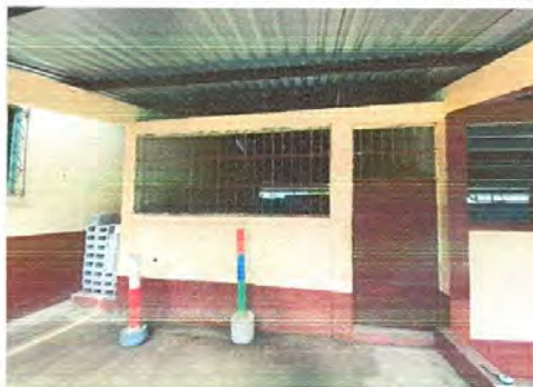
Foto 11: Mantenimiento a estructura de puerta de metal de 1.00x2.50 mts, Mantenimiento a balcón de metal de 1.19x2.70 mts en aula 3
