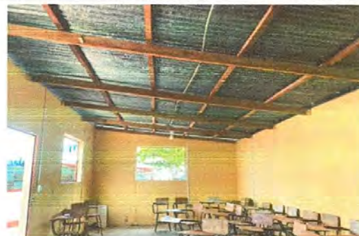
Foto 2: Sustitución de focos por lamparas led empotrables redondas, Sustitución de interruptor doble, Sustitución de tomacorrientes dobles, instalación de ventiladores de techo en aula de computación
