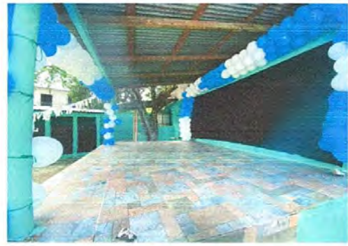
Foto 8: Sustitución de estructura de soporte de madera por metal en el techo, sustitución de lamina por lamina troquelada aluzinc calibre 26, Pintura en muros exteriores en el escenario
