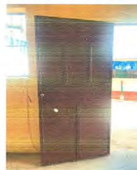
Foto 6: Mantenimiento a estructura de puerta de metal de 1.05x2.11 mts(cepillado y pintura,desinstalar e instalar ) en aula de computación
