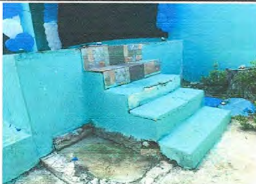
Foto 9: Reparación de gradas de block , Sustitución de piso cerámico deteriorado por piso cerámico antideslizante en gradas
