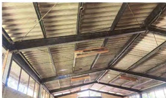
Foto 3: Sustitución de lamparas por lamparas led en el salon de usos multiples
