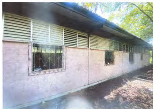
Foto 10: Sustitución de ventana de persiana por ventana-balcón de metal de 3.90x0.90 mts en el aula 1 y 2
