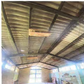
Foto1: Sustitución de lamina duralita por lamina troquelada aluzinc calibre 26, Sustitución de capote de duralita para lamina troquelada en el salon de usos multiples
