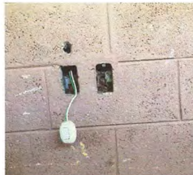
Foto 2: Sustitución de tomacorrientes dobles, Sustitución de interruptores simples en el salon de usos multiples
