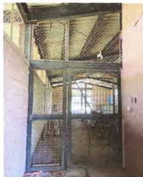
Foto 7: Mantenimiento a estructura de puerta de metal de 1.90x3.00 mts
