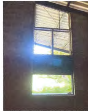
Foto 8: Sustitución de ventana de persiana por ventana de pvc de vidrio transparente de 1.10x1.03 con cedazo en el salon de usos multiples
