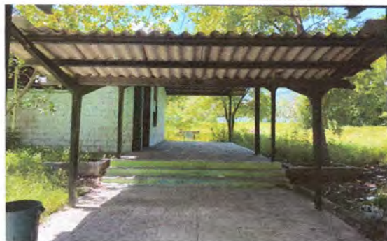
Foto 9: Sustitución de lamina duralita por lamina troquelada aluzinc calibre 26 en el corredor
