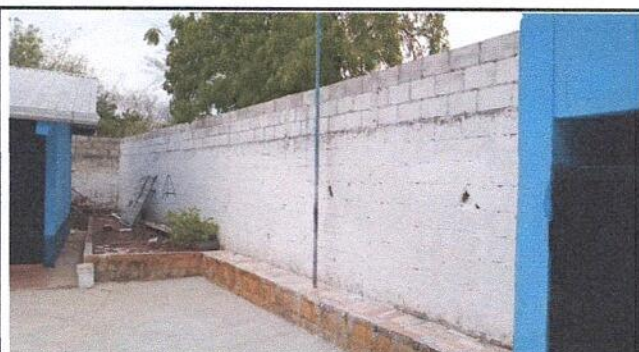
Foto 11: Repellos, Cernidos y Pintura en Muros
