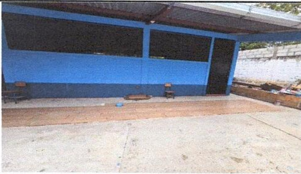
Foto 3: Instalación de Ventana PVC en Aulas
