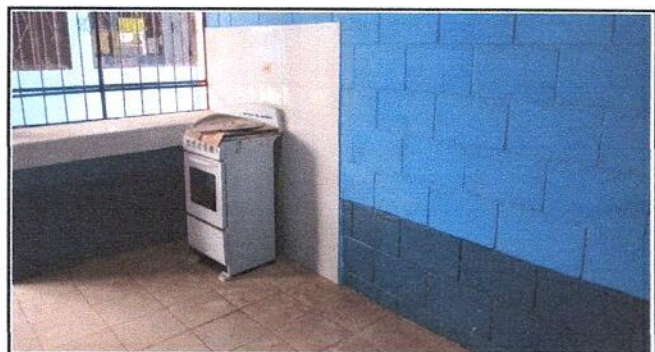
Foto 6: Instalación de Mueble de Concreto y Azulejo en Cocina
