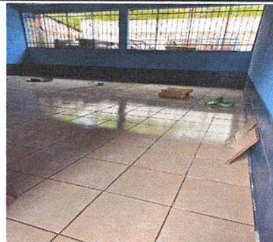
Foto 4: Instalación de Ventana PVC y Remoción de balcones en Aulas
