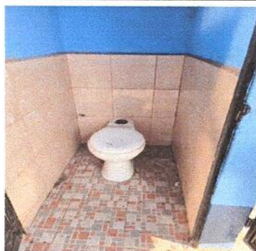
Foto 7: Sustitución de Inodoros en Baños
