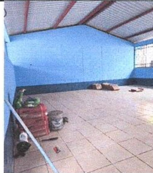
Foto 2: Instalación de Cielo Falso PVC en Aulas
