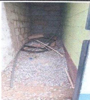
Foto 9: Instalación de Piso de Concreto en Bodega
