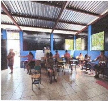
Foto 1: Instalación de Cielo Falso PVC en Aulas
