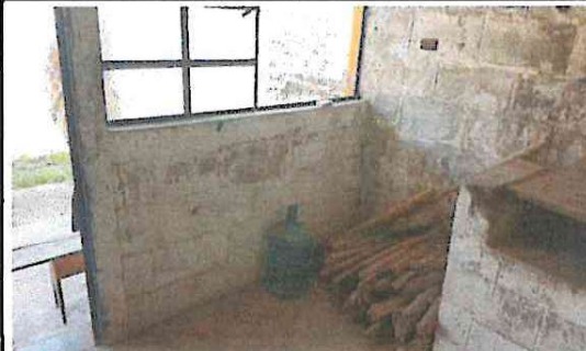
FOTO 2: Instalación de desayunoador de concreto con azulejado en cocina.
