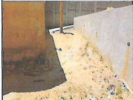
FOTO 8: Sustitución de planchas de concreto en patio.
