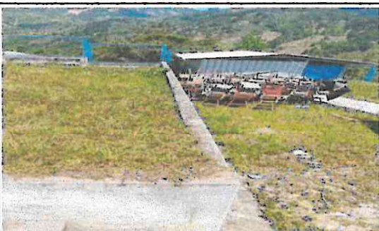
FOTO 5: Instalación de malla con tubo galvanizado en muros.
