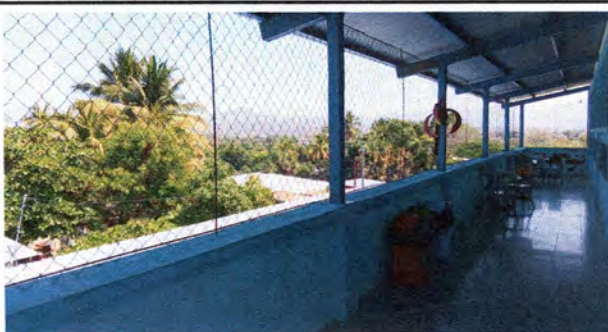
Foto 5: Sustitución de malla y varilla por barandal metalico de tubo rec chapa 18
