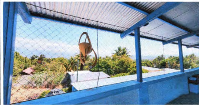
Foto 7: Sustrución de malla y varilla por barandal metalico de tubo rec chapa 18
