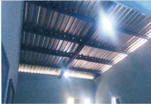
Foto1: Suministro e Instalacion de Cielo Falso tipo termoport
