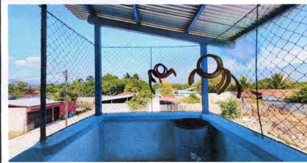
Foto 9: Sustrución de malla y varilla por barandal metalico de tubo rec chapa 18
