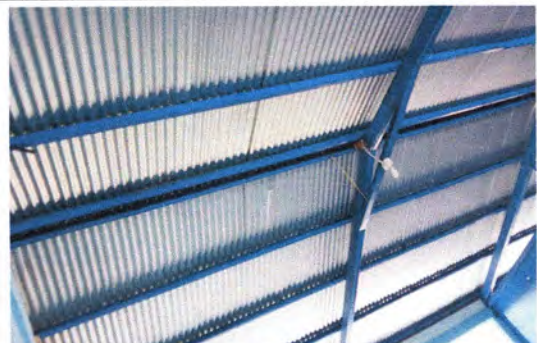
Foto 2: Suministro e Instalacion de Cielo Falso tipo termoport
