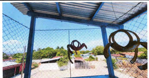
Foto 6: Sustitución de malla y varilla por barandal metalico de tubo rec chapa 18
