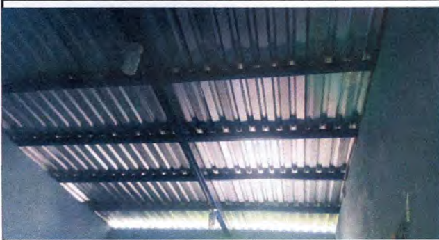
Foto 3: Suministro e Instalacion de Cielo Falso tipo termoport
