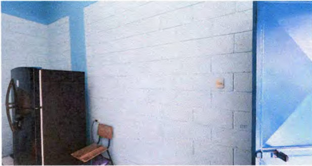
Foto 13: Aperturación de Vano y tallado Y colocacion de ventanda de pvc corrediza he instalacion de balcon en la cocina (parte de adentro)
