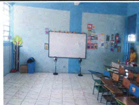
Foto 10: Instalacion de pared de material tabla yeso para división del aula
