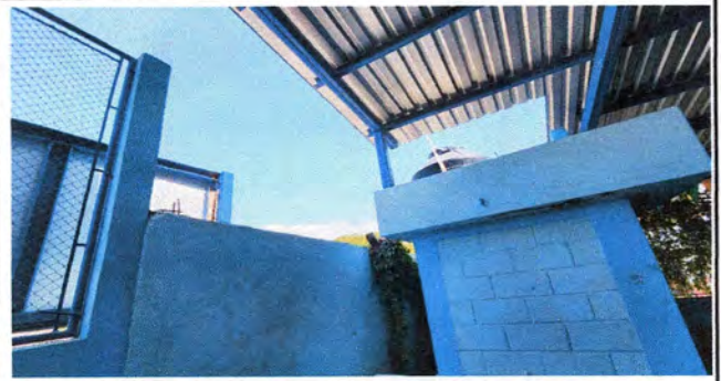
Foto 16: Instalación de 6 mt de hiladas de block y aplicación de repello
