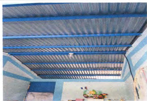
Foto 4: Suministro e Instalacion de Cielo Falso tipo termoport
