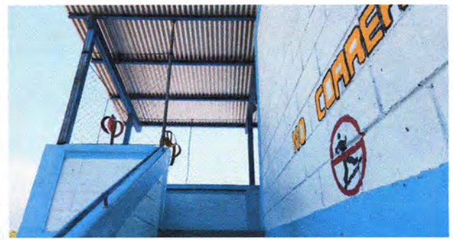
Foto 8: Sustrución de malla y varilla por barandal metalico de tubo rec chapa 18
