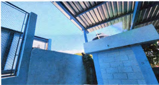
Foto 15: Instalación de 6 mt de hiladas de block y aplicación de repello
