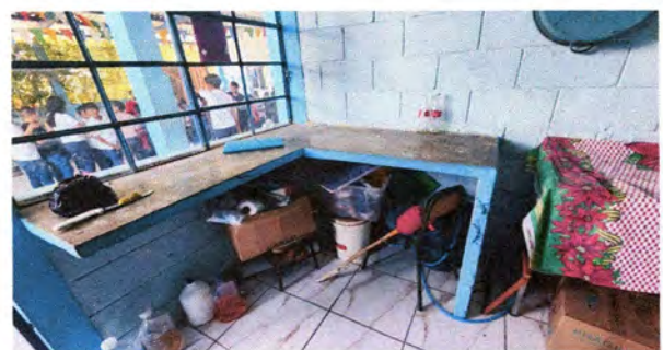
Foto 12: Instalación de lavatrastos inox con griferia con sus accesorios
