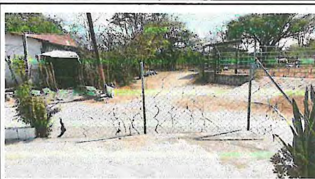
Foto 2: Sustitución de tubo y malla por tubos galvanizados y malla con privacinta y razor
