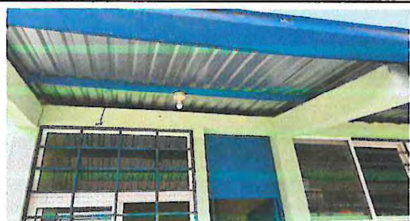
Foto 5: Instalacion de sellado hermetico con concreto en la parte que divide la pared con la lamina del aula, cocina Y baños (para evitar que entren animales o insectos )
