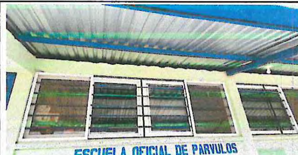
Foto 6: Instalacion de sellado hermetico con concreto en la parte que divide la pared con la lamina del aula, cocina Y baños (para evitar que entren animales o insectos )
