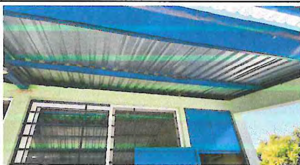
Foto 7: Instalacion de sellado hermetico con concreto en la parte que divide la pared con la lamina del aula, cocina Y baños (para evitar que entren animales o insectos )
