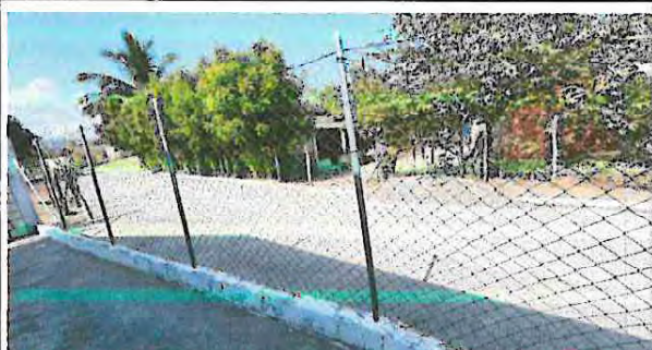
Foto 4: Sustitución de tubo y malla por tubos galvanizados y malla con privacinta y razor
