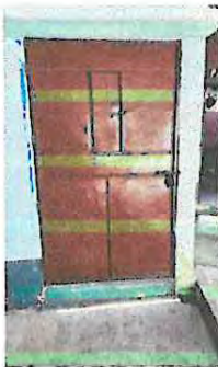
Foto 3: Sustrucción de puerta metálica con dimensiones de 1.12x2.01m en el ingreso del establecimiento
