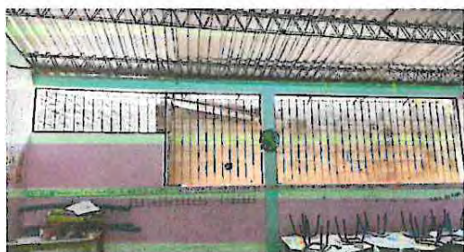
Foto 13: Instalacion y suministro de cielo falso en las aulas y dirección
