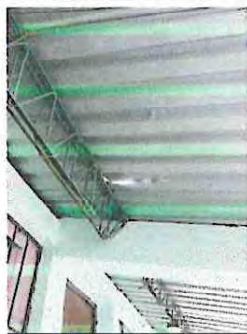
Foto 9: sustitucion de laminas en mal estado en la aula No.1
