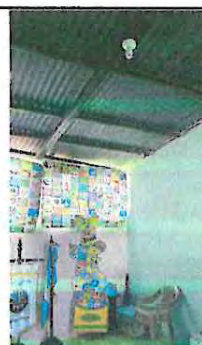
Foto 16: Instalacion y suministro de cielo falso en las aulas y dirección
