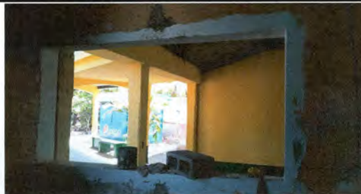
Foto 6: Renglón 2. Instalación de ventana de PVC con la cualidad especial de que será fabricada a doble hoja. Se agrega una foto de referencia en la Foto 1 del PRA-FOR-123 versión 1, hoja 2 de este formulario. Este tipo de ventana se considera necesaria porque serán utilizadas para servir los alimentos a los estudiantes, por lo que se necesita tener amplitud y aprovechar al máximo el espacio.
