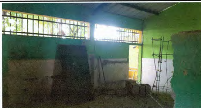
Foto 3: Renglón 22 levantado de block para tapar entradas a cocina.
