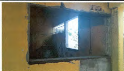
Foto 5: Renglón 2. Instalación de ventana de PVC con la cualidad especial de que será fabricada a doble hoja. Se agrega una foto de referencia en la Foto 1, del PRA-FOR-123 versión 1, hoja 2 de este formulario. Este tipo de ventana se considera necesaria porque serán utilizadas para servir los alimentos a los estudiantes, porque se necesita tener amplitud y aprovechar al máximo el espacio.
