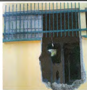
Foto 4: Renglón 2. Se realizará sustitución de estructura de metal y se instalará ventana de pvc, con la cualidad especial que será fabrica con una apertura total a doble hoja, para aprovechar la ventilación natural al máximo. Se agrega una foto de referencia en la foto 1, del Pra-For-123 versión 1 hoja 2 de este formulario.
