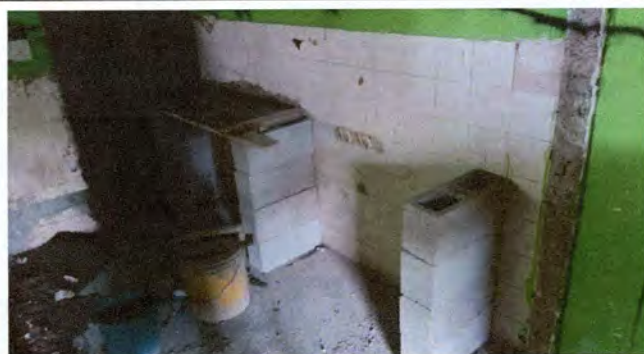
Foto 2: Renglón 21. Reparación de mueble de cocina, tallado y azulejado, se realizará un polletón de 14.24 M2 el cual será cubierto por azulejo y tallado con cernido por motivo de tener un espacio higiénico por su fácil limpieza, para la preparación de la comida.
