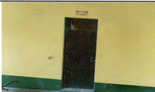
Foto 1. Renglón 1. Sustitución de puerta, se incluye la fabricación y la instalación. Así también se manifiesta que la puerta es con diseño, de metal e incluye una chapa antipánico, la cual es un dispositivo de seguridad que facilita la apertura rápida y segura de la puerta en situaciones de emergencia. Se incluye fotografías en la foto 2 y foto 3 de este formulario en la hoja 1.
