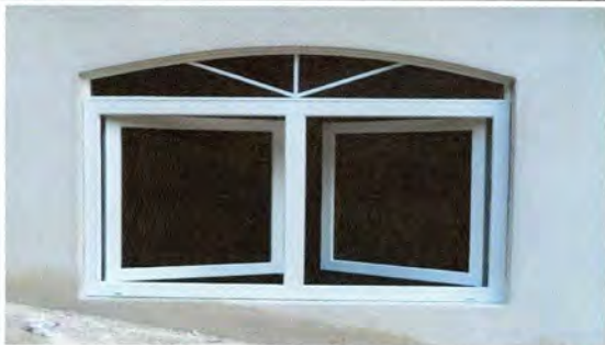
Foto1: Este es el diseño de la ventana de pvc con apertura a doble hoja que se instalarán en las 4 ventanas ubicadas según fotografías en la versión 1 del formulario, foto 4, 5 y 6, se considera necesario este diseño para aprovechar al máximo el espacio.
