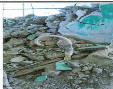
Foto 6: Los renglones 5, 6, 7, 8 y 9 contemplan instalación de tubería principal y aguas negras, sustitución de tubería de línea principal, instalación de tubería para agua potable incluye accesorios y tangit, sustitución de caja de registro. Se hace mención que el lugar donde se está realizando la cocina eran unos servicios sanitarios que estaban deteriorados en su totalidad, porque las tuberías fueron averiadas por raíces de los árboles. Esta fotografía también es para respaldar el renglón 12 y 13 sustitución de chorros e instalación de chorros.
