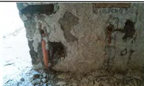
Foto 5: Los renglones 5, 6, 7, 8 y 9 contemplan instalación de tubería principal y aguas negras, sustitución de tubería de línea principal, instalación de tubería para agua potable incluye accesorios y tangit, sustitución de caja de registro. Se hace mención que el lugar donde se está realizando la cocina eran unos servicios sanitarios que estaban deteriorados en su totalidad, porque las tuberías fueron averiadas por raíces de los árboles. Esta fotografía también es para respaldar el renglón 12 y 13 sustitución de chorros e instalación de chorros.
