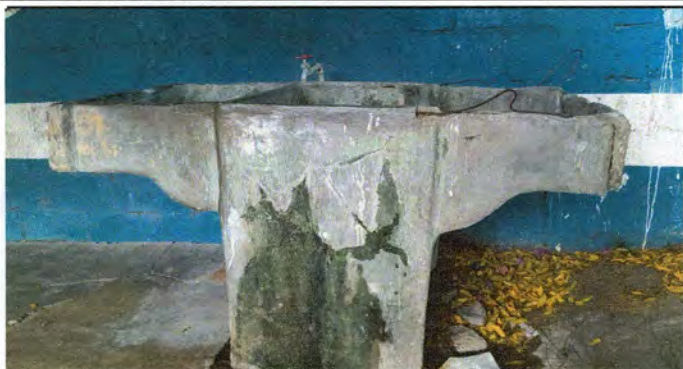
Foto1: Renglón 11 y 12. Sustitución de pila de cemento, por una nueva de cemento de dos lavaderos, la instalación de esta pila lleva su tubería.
