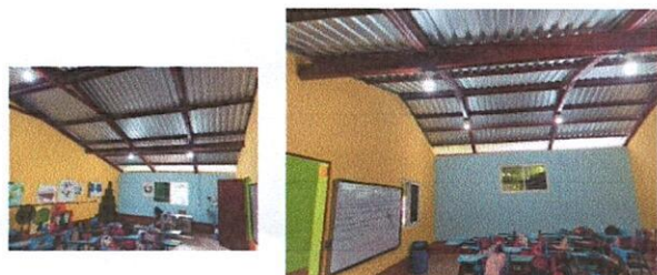
Foto 3: Suministro e instalacion de cielo falso tipotermoport 2x2ft en el area de computación
