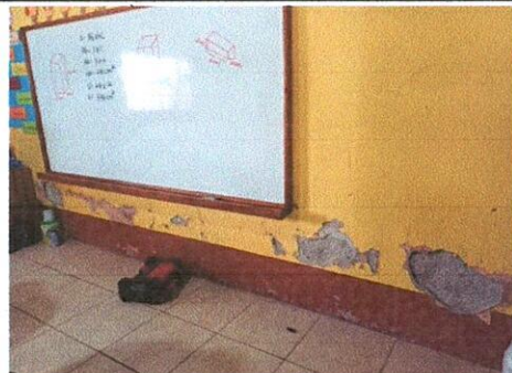
Foto 10: Sustitución de repello dañado por hongo por repello premezclado blanco en las aulas 1ro, 2do y 6to y pintado en el interior de las aulas
