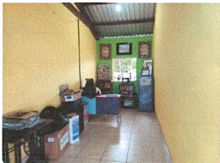
Foto1: Suministro e instalacion de cielo falso tipotermoport 2x2ft en el area de dirección
