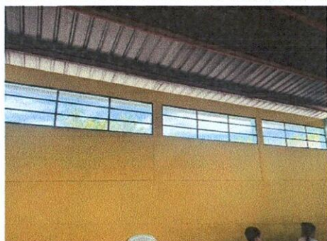
Foto 7: Sustitución de de ventanas por ventanas pvc de 060x 2.30 mts en las aulas de 3ro y 4to
