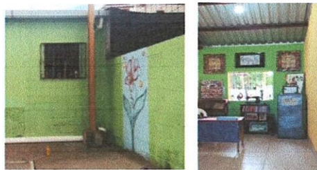
Foto 2: Apertura de vano para la instalacion de puerta de pvc en el area de dirección
