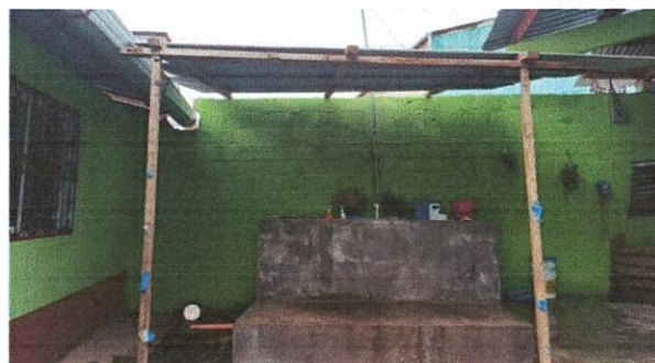
Foto 4: Sustitución de estructura de madera por estructura de metal e instalacion de lamina troquelada cal26 en el area de la pila
