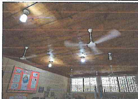
Foto 8: Sustitución de lamparas por lamparas tipo panel de 2x2
