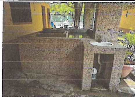
Foto 10: Instalacion de drenaje para lavamanos
