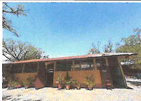
Foto 2: Sustitución de lamina por lamina troquelada prepintada calibre 26
