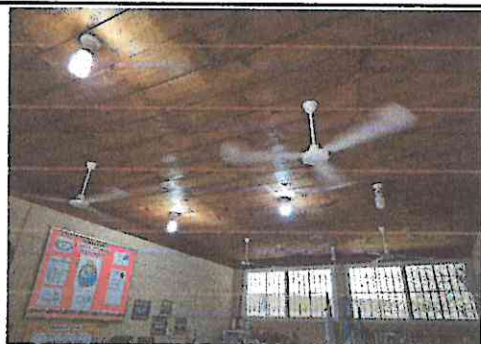
Foto 7: Suministro he instalación de cielo falso tipo termoport de 2x2
