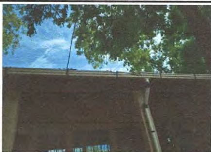
Foto 3: Sustrucción de canal de plastico y bajada de agua de plastico en aulas 9 y 10
