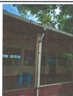
Foto 4: Sustrucción de canal de plastico y bajada de agua de plastico en aulas 9 y 10
