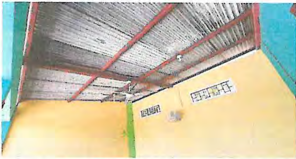
Foto 1: Instalación de Cielo Falso tipo termopor en aulas y dirección y sustitución de sistema de iluminación y instalación de sistema eléctrico en las aulas para la colocación de ventiladores
