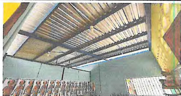
Foto 6: Instalación de Cielo Falso tipo termopor en aulas y dirección y sustitución de sistema de iluminación y instalación de cableado eléctrico en las aulas para la colocación de ventiladores
