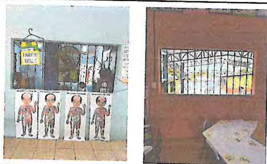
Foto 3: Instalación de ventanas pvc color blanco en las aulas
