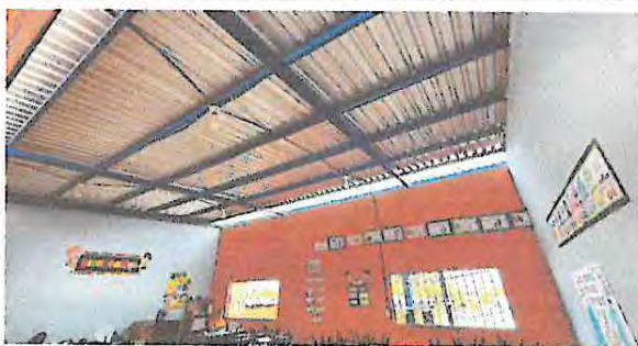
Foto 5: Instalación de Cielo Falso tipo termopor en aulas y dirección y sustitución de sistema de iluminación y instalación de cableado eléctrico en las aulas para la colocación de ventiladores
