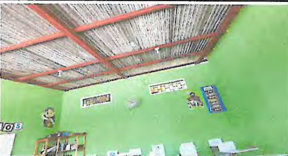
Foto 3: Instalación de Cielo Falso tipo termopor en aulas y dirección y sustitución de sistema de iluminación y instalación de cableado eléctrico en las aulas para la colocación de ventiladores
