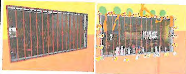
Foto 1: Instalación de ventanas pvc color blanco en las aulas
