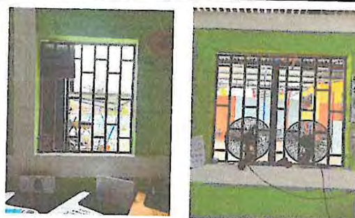
Foto 6: Instalación de ventanas pvc color blanco en las aulas
