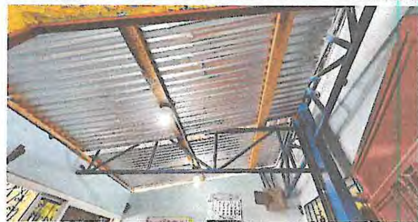
Foto 4: Instalación de Cielo Falso tipo termopor en aulas y dirección y sustitución de sistema de iluminación y instalación de cableado eléctrico en las aulas para la colocación de ventiladores
