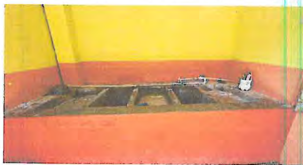
Foto 2: Readecuacion de tubería de agua potable en el area de la pila y cambio de chorros
