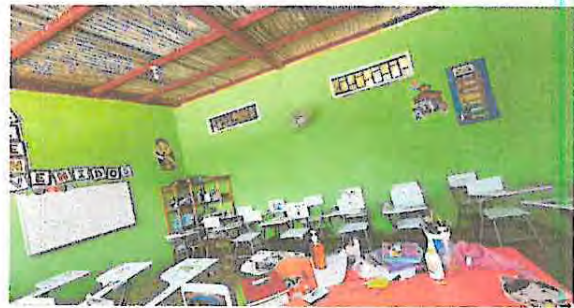
Foto 2: Instalación de Cielo Falso tipo termopor en aulas y dirección y sustitución de sistema de iluminación y instalación de sistema eléctrico en las aulas para la colocación de ventiladores
