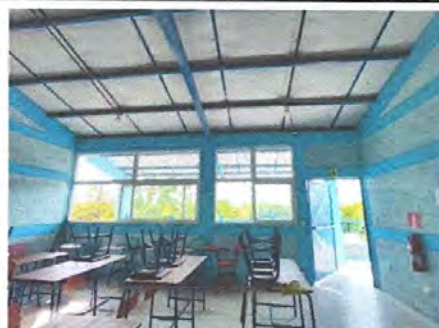
Foto 2: Suministro e instalacion de cielo falso tipotermoport 2x2ft en las aulas y reparación de cableado electrico he instalacion de lamparas tipo panel led 2*2
