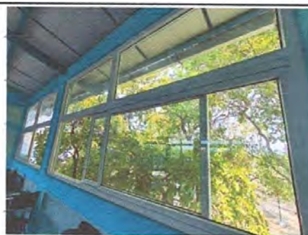
Foto 4: Instalacion de balcones de 3.15 x1.80 por el lado exterior del establecimiento
