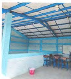
Foto 3: Suministro e instalacion de cielo falso tipotermoport 2x2ft en las aulas y reparación de cableado electrico he instalacion de lamparas tipo panel led 2*2
