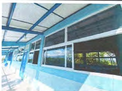
Foto 5: Instalacion de balcones de 3.15 x1.80 por el lado interior del establecimiento
