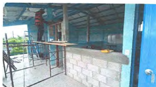
Foto 6: Instalación de una ventana de 1.82*1.82 mts y de Instalación de puerta de metal de 1.20*2.20 mts con chapa
