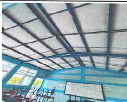
Foto1: Suministro e instalacion de cielo falso tipotermoport 2x2ft en las aulas y reparación de cableado electrico he instalacion de lamparas tipo panel led 2*2
