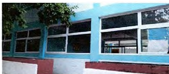
Foto 5: Instalacion de balcones de 2.79x1.60 en La parte de enfrente y de atrás en las aulas (6 balcones por la parte de afuera )
