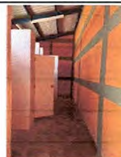
Foto 6: Suministro he Instalacion del sistema electrico en el area del baño ( incluye colocación de 7 lamparas ahorradoras led, en el are de adentro, 3 reflectores en el area exterior, 1 apagador, 1 lamapara exterior, 3 way)
