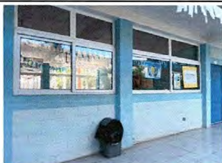
Foto 3: Instalacion de balcones de 2.79x1.60 en La parte de enfrente y de atrás en las aulas (7 balcones por la parte de adentro)
