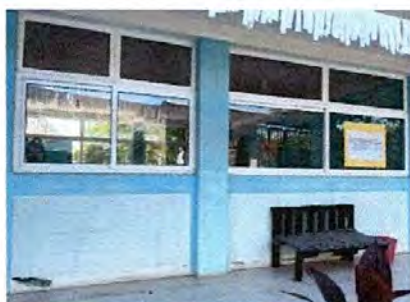
Foto 1: Instalacion de balcones de 2.79x1.60 en La parte de enfrente y de atrás en las aulas (7 balcones por la parte de adentro)
