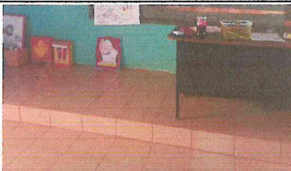
Foto 8: Sustitución de Piso Cerámico IP-IV similar al de las Aulas de Primaria. Para AULA 3 DE CEIN-PAIN.
