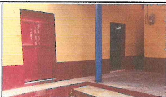
Foto 9: Cerramiento de Vano de Puerta y Sustitución de Puerta Metálica para 2 AULAS DE CEIN-PAIN.
