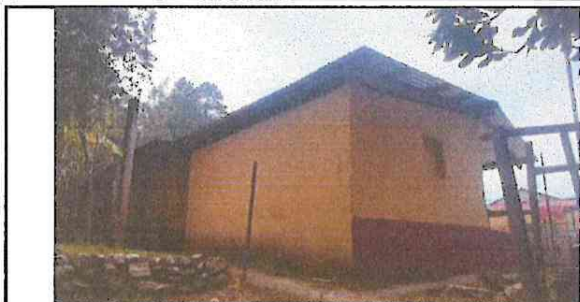
Foto 7: Sustitución de Techo de Lamina Troquelada y Sustitución de Tendales por Costaneras. Para CEIN-PAIN.
