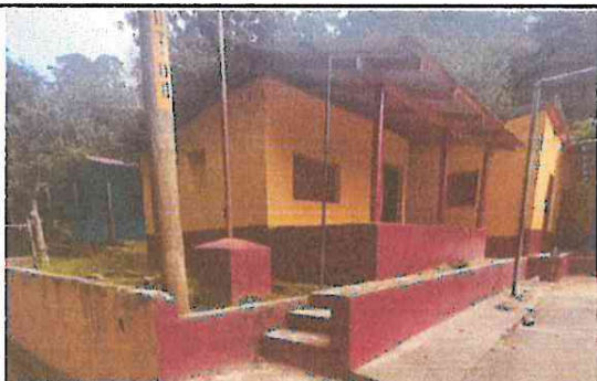
Foto 11: Sustitución de Puerta Metalica, Sustitución de Ventana Balcones, Sustitución de Piso de torta de Concreto y Sustitución de Piso Ceramico., Para CEIN-PAIN.
