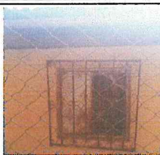
Foto 8: Sustitución de Puerta Metalica, Sustitución de Ventana Balcones. Para CEIN-PAIN.
