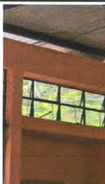
Foto 12: 1.12. Fabricación e instalación de balcón de metal parte de la salida a los baños mide 0.80x2.80 m2
