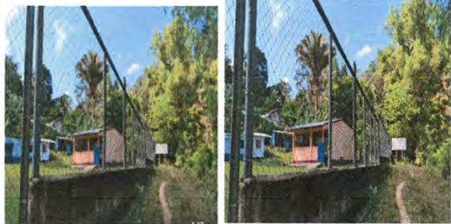
Foto 18: 3.1. Pintura de muro perimetral de enfrente de la Escuela de interior y exteriores 260 m2
