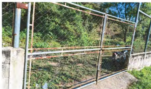
Foto 20: 3.3. Sustitución de porton de malla por deterioro a porton corredizo que mide 4.40x2.50; 11m2
