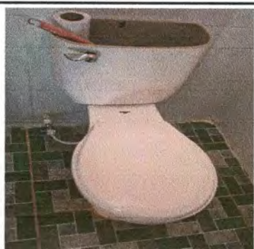
Foto 16: 2.4. Sustitución de sanitario por deterioro
