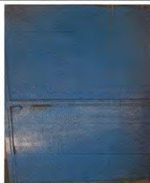
Foto 4: 1.3.Puerta de aula lijada y pintura 2x1 m2
