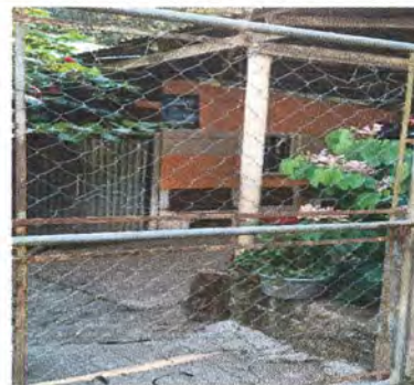
Foto 19: 3.2. Sustitución de puerta de malla a puerta de metal con acceso a un costado de la escuela de dos hojas 1.50x2; 3 m2
