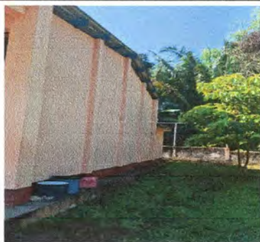
Foto1: 1.1. Pintura de aula de interiores y exteriores 350m2
