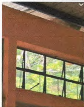
Foto 8: 1.8. Sustitución de ventana de metal por ventana de PVC y su Cedazo color blanco parte de la salida a los baños mide 0.80x2.80; 2.24 M2
