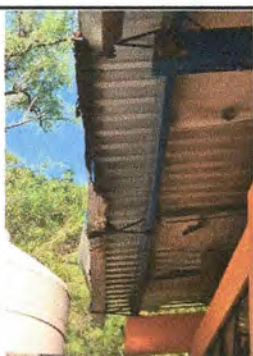
Foto 5: 1.4.Sustitución de canal de metal por deterioro a canal de metal 19 mts lineales
