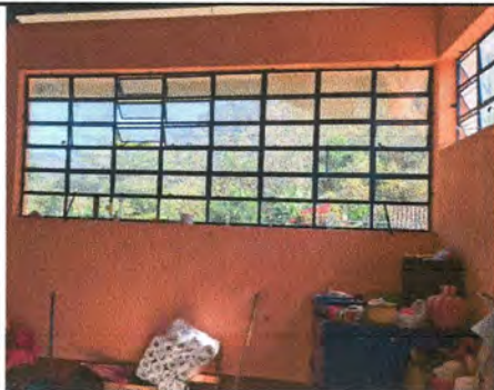
Foto 7: 1.6. Sustitución de ventana de metal por ventana de PVC y su cedazo, color blanco parte de enfrente de aula mide 1.65x4 m2
