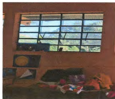
Foto 9: 1.9. Fabricación e instalación de balcón de metal de enfrente de aula mide 1.60x2.50 m2
