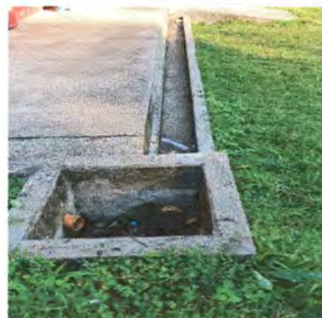
Foto 20: 3.4. Fabricación de rejilla para cuneta de aguas fluviales de medidas de 0.30x7 y 1x1 m2; 3.10 m2
