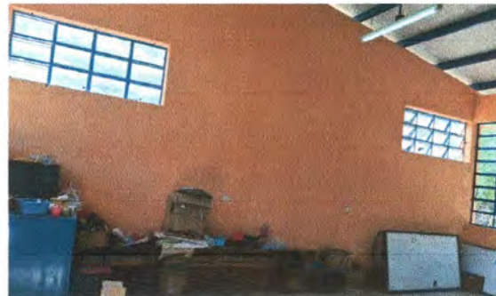
Foto 7: 1.7. Sustitución de ventana de metal por ventana de PCV y su cedazo colo blanco parte de atrás del aula mide 1x2; 2 unidades
