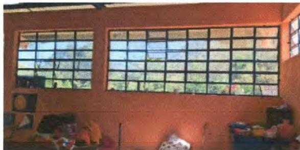
Foto 2: 1.1.Pintura de aula de interiores y exteriores 350m2
