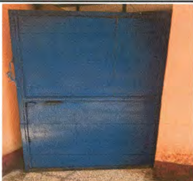
Foto 3: 1.2.Puerta de aula principal lijada y cambio de 2x1 m2
