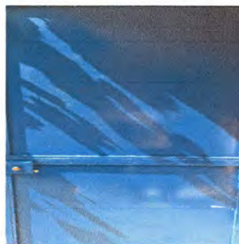
Foto 13: 2.1. Puerta principal de baños lijada y pintada 1x2 m2
