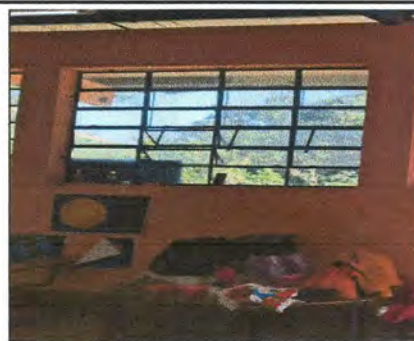
Foto 6: 1.5.Sustitución de ventana de metal por ventana de PVC y su cedazo, color blanco parte de enfrente de aula mide 1.60x2.50 m2
