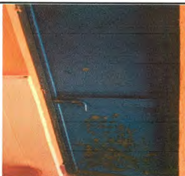
Foto 14: 2.2. Puerta de baños lijadas y pintadas de 0.75x1.60x2; 2.40 m2
