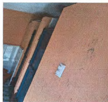
Foto 15: 2.3. Pintura de baños 50 m2
