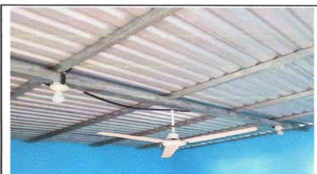
Foto 10: Sustitución de Ventiladores en aulas
