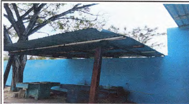
Foto 3: Ampliación de muro perimetral 3 hiladas de block sobre muro existente.
