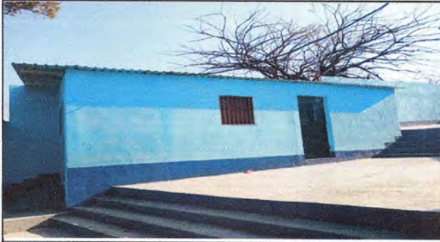
Foto 1: Ampliación de cocina: Ampliación de ventana de 0.80*0.85 (demolición) 0.68 M2
