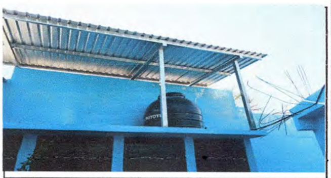
Foto 6: Suministro e instalación de depósito de agua de 1,100 lts a la par del existente para mayor captación porque no se da abasto el agua necesaria para los sanitarios por irregularidad del servicio de agua
