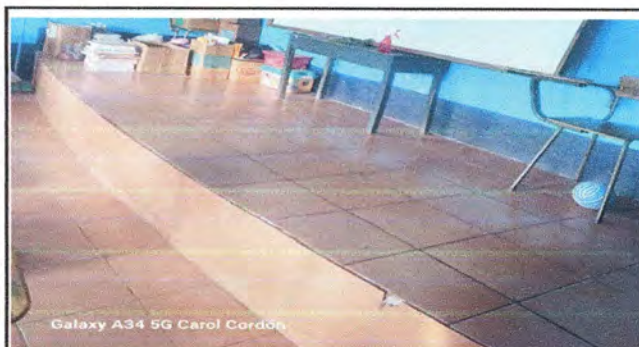
Foto 9: Ampliación de aula (Demolición de pequeño escenario, fundición de torta de cemento e instalación de piso cerámico)
