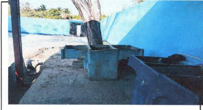
Foto 4: Sustitución de Pila Prefabricada por Pila de Concreto de 2.4*1.2
