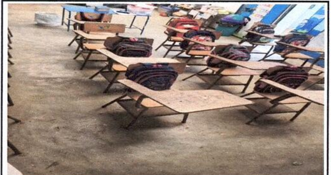
Foto 16: SUSTITUCIÓN DE PISO DE CEMENTO POR PISO CERAMICO, EN AULA
