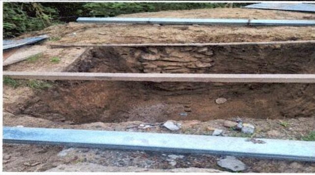
Foto 19: AREA DONDE IRA COLOCADO EL TANQUE SEPTICO.
