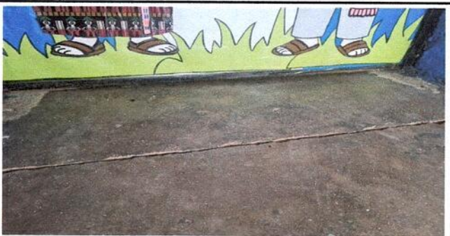
Foto 17: SUSTITUCIÓN DE PISO DE CEMENTO POR PISO CERAMICO, EN AULA
