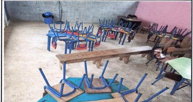
Foto 14: SUSTITUCIÓN DE PISO DE CEMENTO POR PISO CERAMICO, EN AULA.
