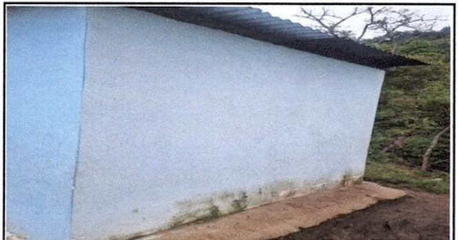
Foto 22: PINTURA EN MUROS DE SANIRATIOS.
