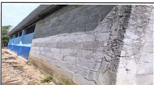
Foto 4: REPELLO Y CERNIDO EN MURO EXTERIOR
