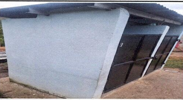
Foto 23: PINTURA EN MUROS DE SANITARIO.
