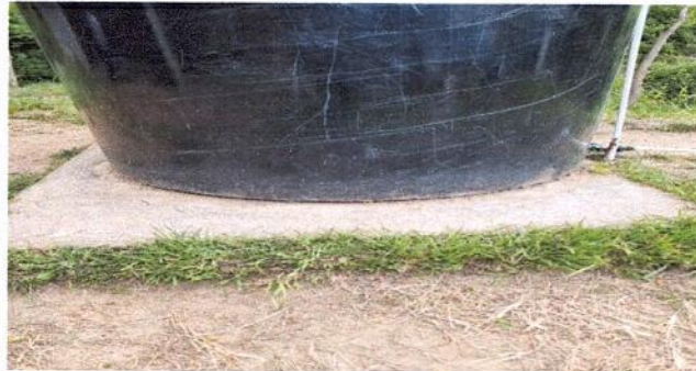
Foto 10: FABRICACIÓN DE BASE DE CEMENTO PARA ROTOPLAST, COMO SE VE EN LA IMAGEN, ESTA A LA ALTURA DEL SUELO, ES NECESARIO ELEVARLA UN POCO.
