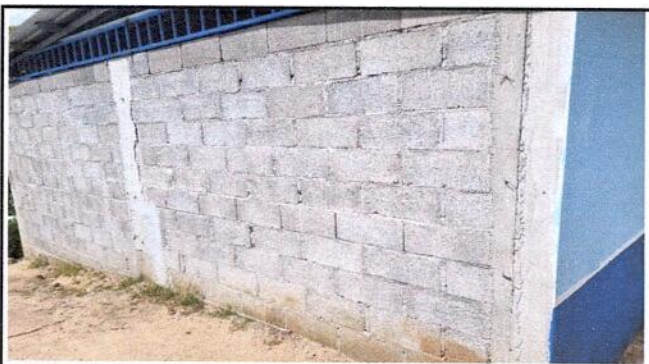
Foto 3: REPELLO Y CERNIDO EN MURO EXTERIOR
