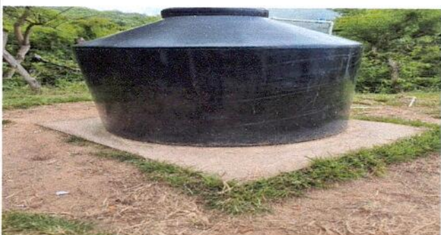
Foto 9: FABRICACIÓN DE BASE DE CEMENTO PARA ROTOPLAST RAZON ESTA MUY BAJITA Y NECESITO QUE BAGE EL AGUA CON MAS PRESIÓN, PARA LOS SANITARIOS Y PARA LA COCINA, Y PARA DARLE UNA MEJOR PROTECCIÓN PARA QUE NO SER LLENE DE TIERRA CUANDO LLUEVE.
