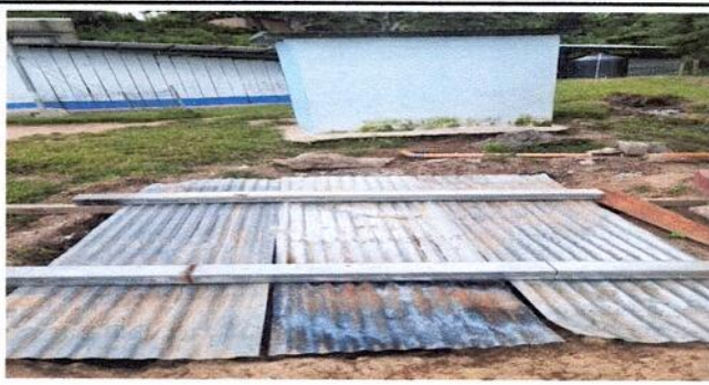
Foto 21: AREA DONDE IRA COLOCADO EL TANQUE SEPTICO
