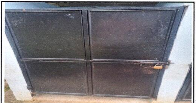
Foto 24: MANTENIRINTO A PUERTAS DE SANITARIOS
