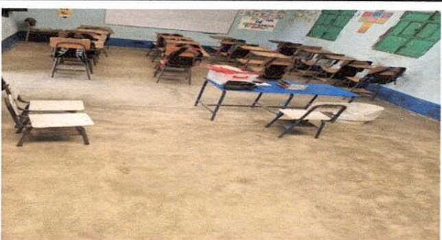
Foto 15: SUSTITUCIÓN DE PISO DE CEMENTO POR PISO CERAMICO, EN AULA
