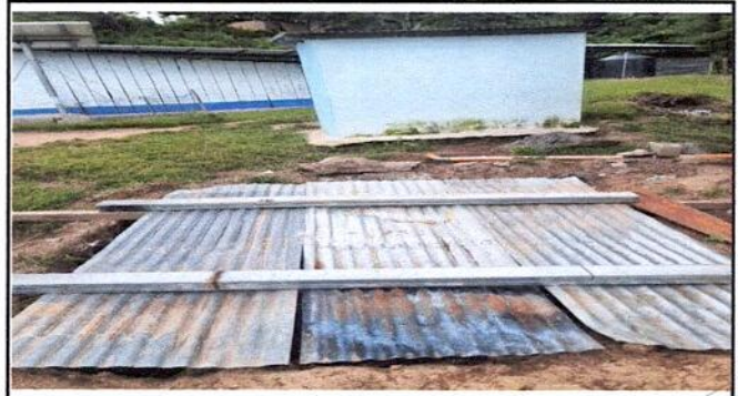
Foto 20: AREA DONDE IRA COLOCADO EL TANQUE SEPTICO
