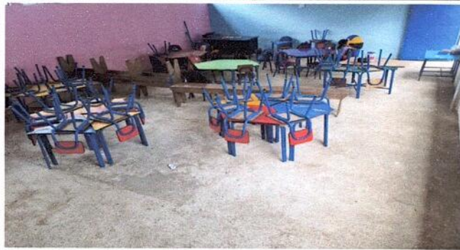
Foto 13: SUSTITUCIÓN DE PISO DE CEMENTO POR PISO CERAMICO, EN AULA.
