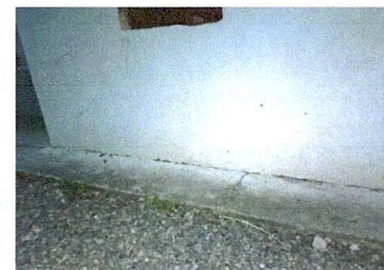
Foto 8. Sustrucción de cera de concreto y banquetas con grietas
