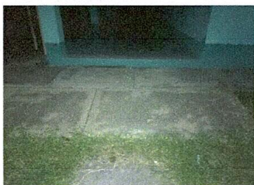
Foto 17: Mnatenimiento de banquetas de concreto
