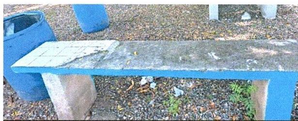
Foto 9: Reparación de banquetas de concreto con cerámico
