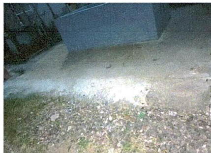
Foto 14. demolicion de torta de cemento mt2
