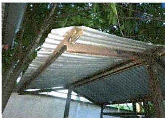
Foto 13. Sustrucion de lamina y costanera de galera para dos mesas donde comen los niños
