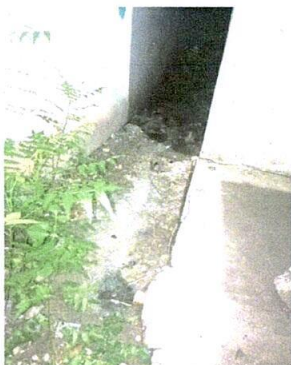
Foto 15. instalacion de tubos para drenajes de agua de pila
