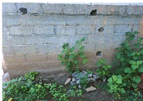
Foto 11: Reparación de paredes con repello y cernido
