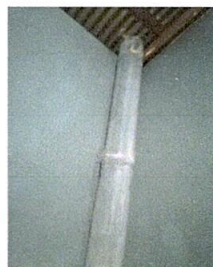
Foto 7. Sustrucción de poyeton con plancha y chimenea de concreto
