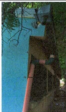
Foto 5: Sustitucion de bajante de agua pluviales y sustitucion de canal de metal por metal
