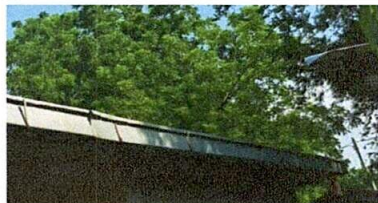
Foto 5: Sustitucion de bajante de agua pluviales y sustitucion de canal de metal por metal
