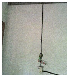
Foto 10: Sustrucción de cable y movilización de tomas corrientes
