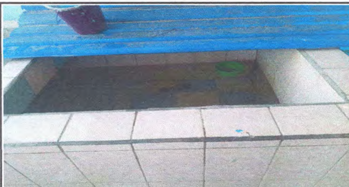
Foto 9: Tapadera de Metal en Pila de Baños
