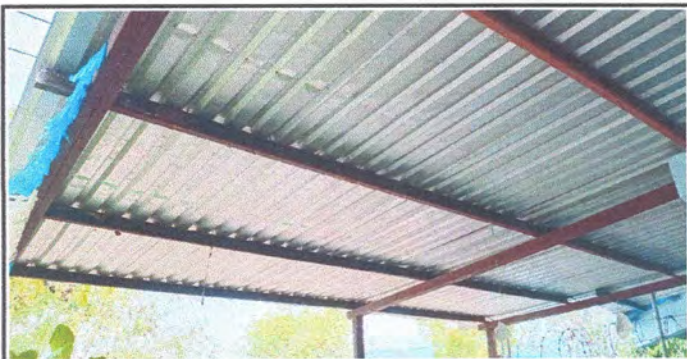
Foto 12: Sustitución de lámina y estructura de Soporte en Galera en Patio
