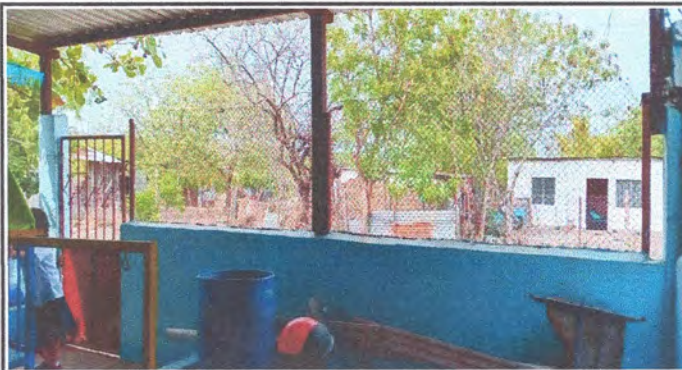
Foto 3: Instalación de Muros de Block a Altura de Columna
