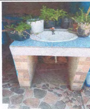
Foto 8: Sustitución de Lavamanos en Baños ( 1.20 mts de Largo, 0.50 mts de alto y 0.75 de ancho)
