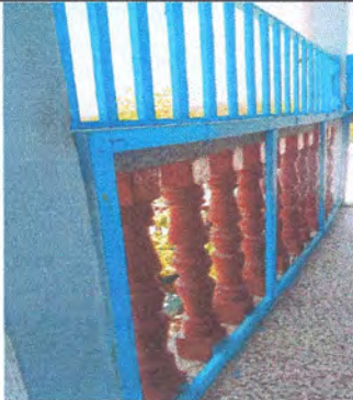
Foto 1: Sustrucción de Baranda de Madera por Baranda de Metal en Aulas de Segundo Nivel.
