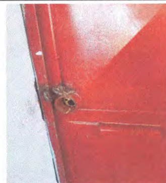
Foto 2: Sustrucción de Chapas en Puertas de Aulas
