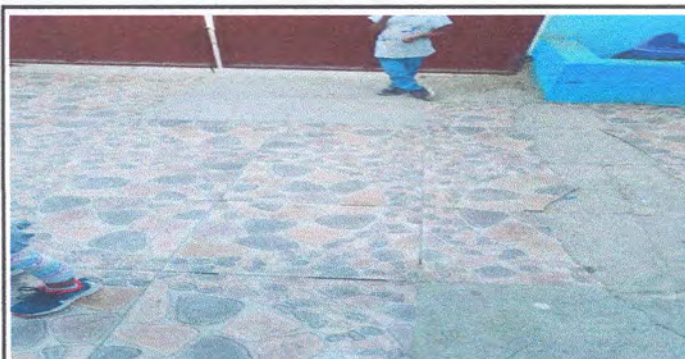
Foto 11: Sustitución de Piso en Patio
