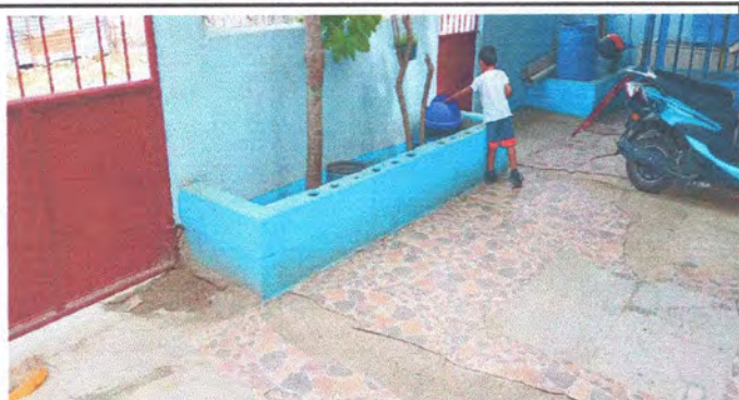
Foto 10: Reparación de Banquetas de Block en Patio (7.5 mts de largo, 0.42 mts de alto y 0.60 de ancho)
