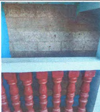
Foto 7: Repellos y Cernidos en Muro Perimetral
