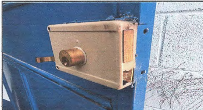
Numeral 2.1 Sustitucion de chapa en mal estado.
