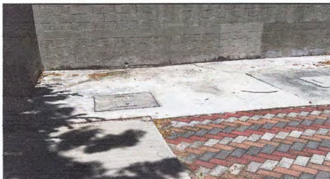
Numeral 4.3 Demoler losa de Pozo de Absorcion y Reponerla. (Losa esta quebrada, salen malos olores, y presenta hundimiento pegada al tapial. (No esta fundida con tapial)
