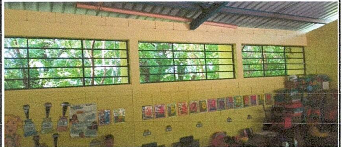
Foto 2: Pintura en muros interiores y exteriores en muros de aulas.
