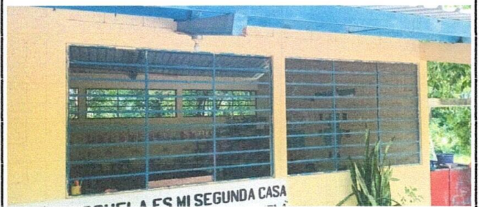
Foto 4: Sustitución de malla en balcones y mantenimiento en aulas.
