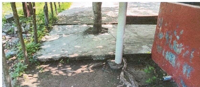
Foto 11: Sustrucción de planchas de concreto en patio.
