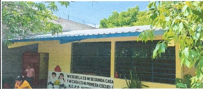
Foto 3: Instalación de canal en aulas.
