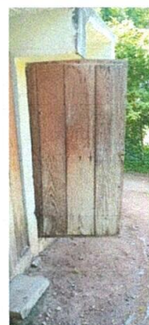
Foto 10: Sustrucción de puertas de madera por puertas de metal de baños.
