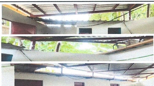
Foto 3: INSTALACIÓN DE RAZOR RIBBON PARA SEGURIDAD DE LA ESCUELA.
