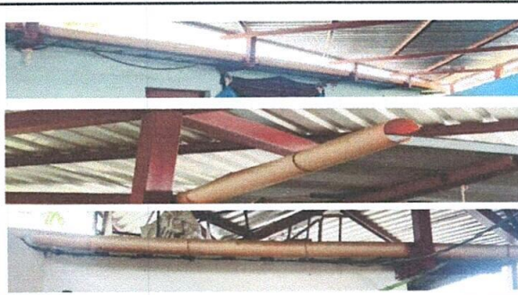
Foto 4: SUSTITUCIÓN DE TUBO DE DRENAJE A CANAL DE METAL
