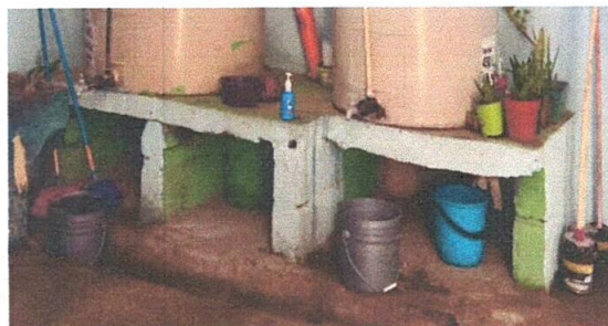
Foto 2: APLICACIÓN DE CERNIDO EN PLANCHA DE CORREDOR
