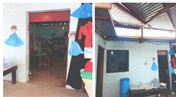
Foto7: TALLADO DE MARCO PARA PUERTAS DE METAL, SUMINISTRO E INSTALACIÓN DE PUERTAS DE METAL (1.01*2.22 c/u)
