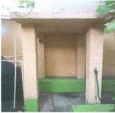
3.3 Foto 13: INSTALACION DE BARANDA DE METAL PARA CIERRE DE BASE DE TANQUE.
