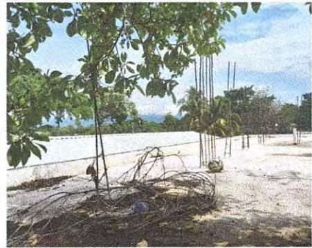
3.1 FOTO 10: INSTALACION DE DEPOSITO DE AGUA DE 1100 LTS.
