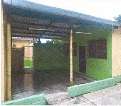
1.7 Foto 8: INSTALACION DE BARANDA DE METAL CON MATERIAL LEGITIMO (division entre patio del aula y cancha).
