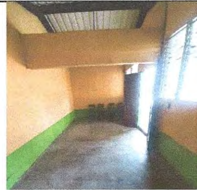
1.4 Foto 4: INSTALACION DE PISO CERAMICO MATE
