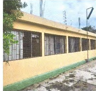
1.2 y 1.3 Foto 2: INSTALACIÓN DE ESTRUCTURA PARA PROTECCION DE SOL EN LAS VENTANAS (TAPASOL).
