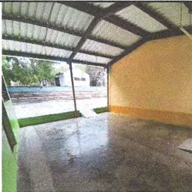
1.4 Foto 3: INSTALACION DE PISO CERAMICO MATE
