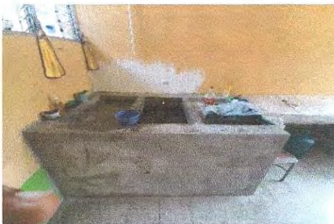
3.2 FOTO 11: INSTALACION DE AZULEJO EN PILA
