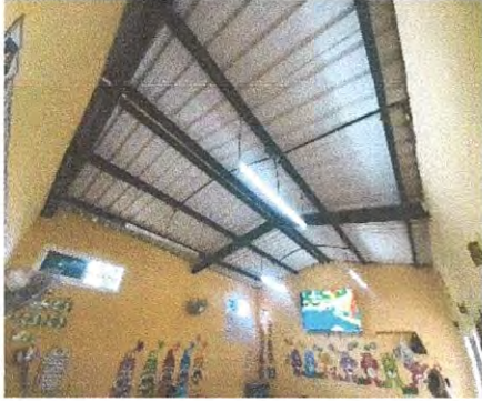
1.1 Foto1: INSTALACION DE CIELO FALSO PVC EN LAS AULAS.
