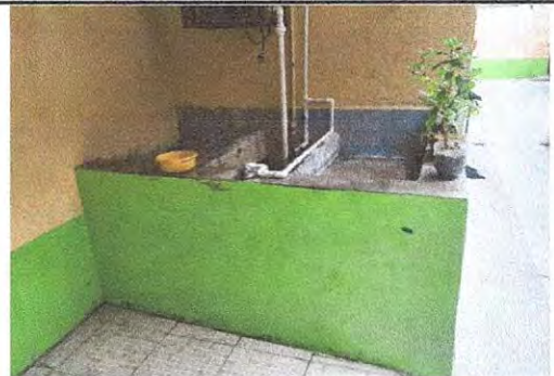
3.2 Foto 12: INSTALACION DE AZULEJO EN PILA
