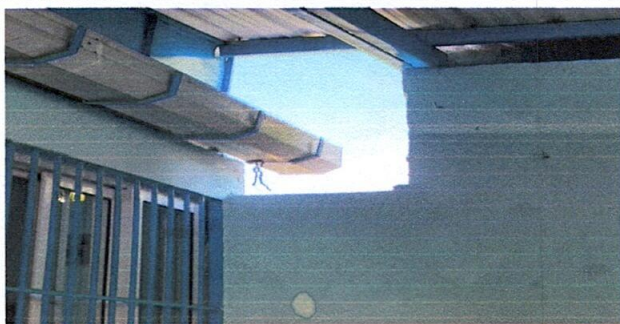
Sellado de ventana en escenario porque se mete el agua
