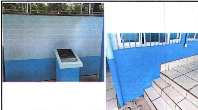
Aplicación de pintura en muros interiores y exteriores (El motivo de la pintura es porque la ves que se pinto se le aplico solo 1 mano de pintura y se ve parchado, y que tambien ya hay partes que estan manchadas)
