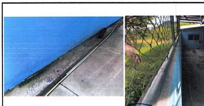
Suministro e instalacion de Facheta en muro del area destinada para comedor, ya que presenta problemas de humedad y no se puede trabajar desde la parte de afuera donde tiene tierra pegada al muro porque el vecino propietario del terreno no da permiso de trabajar.
