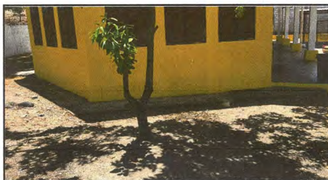
Numeral 3.2 Banquetas hundidas. Ampliacion de Banqueta de concreto a un lateral del establecimiento. AUMENTO DE DIMENSIONES (7.8M DE LARGO, 0.6 DE ANCHO, 0.2 DE ALTO sobre nivel de piso de tierra)
