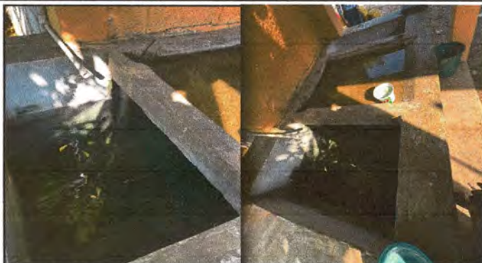
Numeral 2.4 Quitar taponamiento en drenaje de pila, esta tapado. Numeral 2.5 Instalar llave de Chorro. Numeral 2.6 Sustitucion de Losa de Pila (Existente Quebrada) 2.7 Azulejo p/Pila
