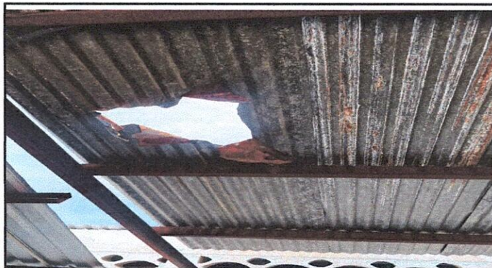
Sustitucion de lamina en mal estado
