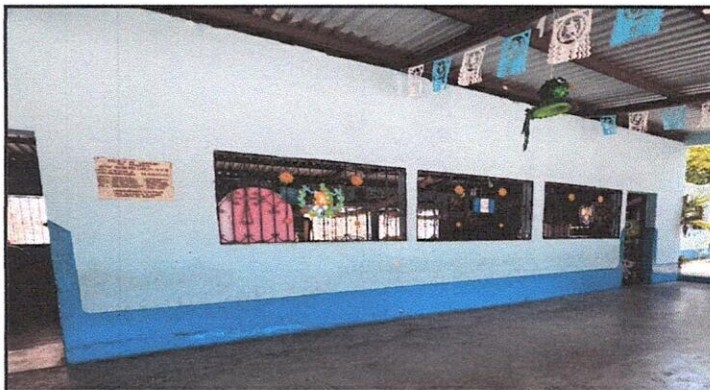
Pintura de muros interiores y exteriores
