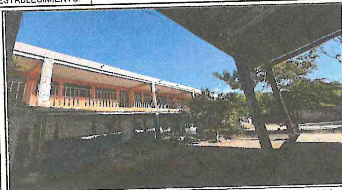
Foto 1: 25 METROS CUADRADOS DE ESTRUCTURA CON LAMINA PARA SOMBRA DE 4 SALONES
