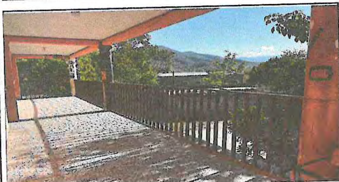
Foto 3: 137.21 MT2 DE SUSTITUCION DE BARANDA METALICA EN SEGUNDO NIVEL.
