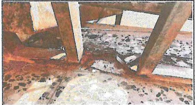
Foto 2: Tubería Destruída
