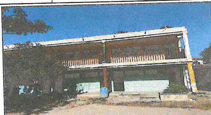
Foto 2: 25 METROS CUADRADOS DE ESTRUCTURA CON LAMINA PARA SOMBRA DE 4 SALONES
