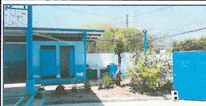
Foto 2: Los servicios sanitarios no cuentan con agua, ya que el servicio es irregular. Se utilizan toneles, por lo que se plantea la construcción de una torre para colocar un depósito aéreo para agua.
