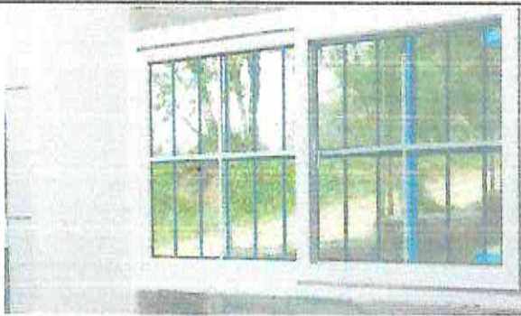
Foto 15: Fabricación e instalación de ventanas pvc en cocina
