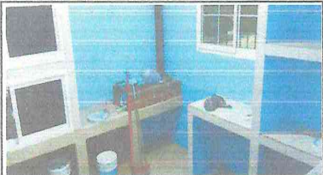
Foto 19: Instalación de azulejo en gabinete de concreto en cocina
