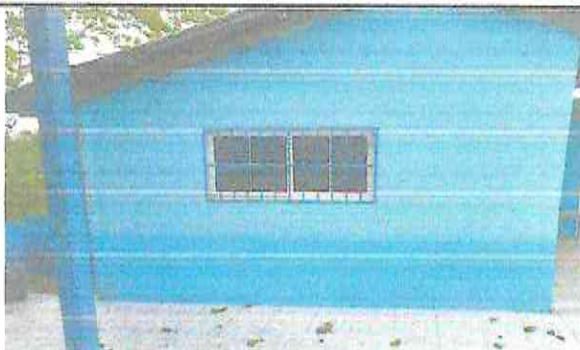
Foto 16: Fabricación e instalación de balcón de hierro en ventana cocina.
