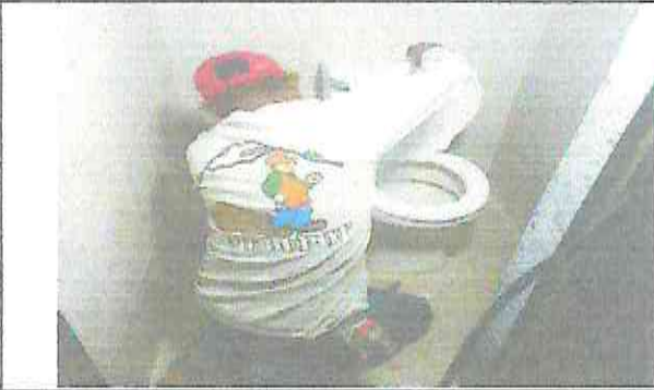
Foto 10: Sustitución de accesorios de sanitarios,
