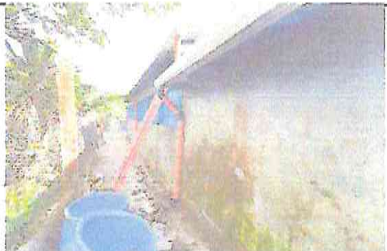
Foto 6: Sustitución de canal de metal, fabricación e instalación, con sus bajantes (parte trasera)
