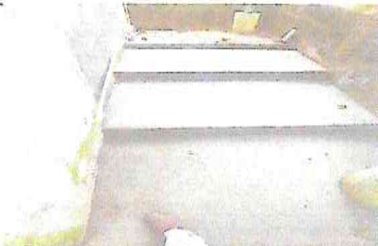
Foto 4: Sustitución de piso natural por torta de cemento
