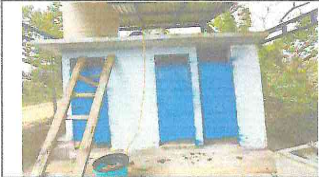
Foto 9: Mantenimiento a estructura (pintura a puertas servicios sanitarios)
