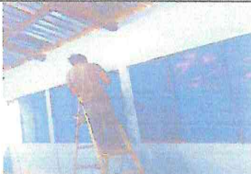
Foto 2: Mantenimiento en ventanas de metal (cepillado, lijado y pintado)
