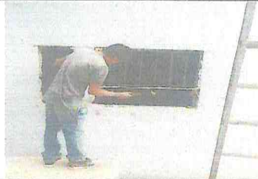
Foto 16: Fabricación e instalación de balcón de hierro en ventana cocina.
