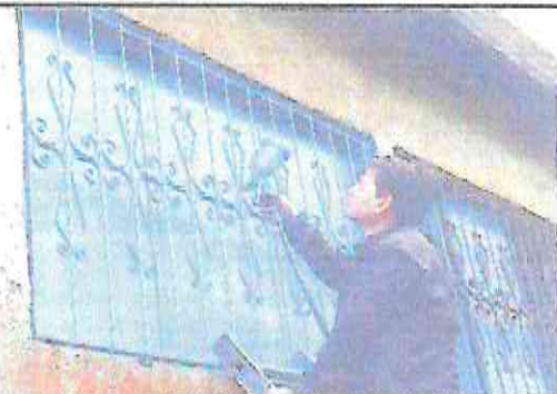
Foto 3: Mantenimiento en balcones de metal (cepillado, lijado y pintado)
