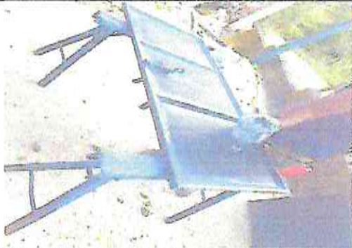
Foto 1: Puertas, Mantenimiento a estructuras (cepillado, lijado y pintado)
