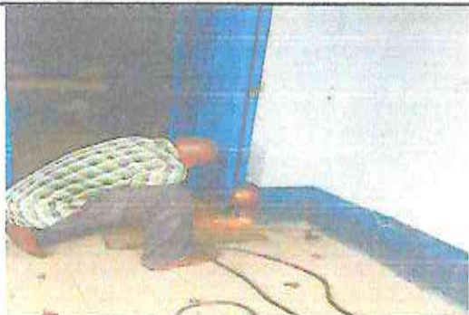
Foto 17: Fabricación e instalación de puerta de metal en modulo de cocina
