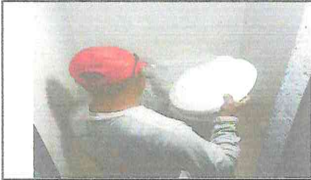
Foto 11: Sustitución de tapaderas de sanitarios
