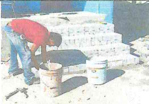
Foto 14: Reparación de plancha de concreto en patio (gradas)
