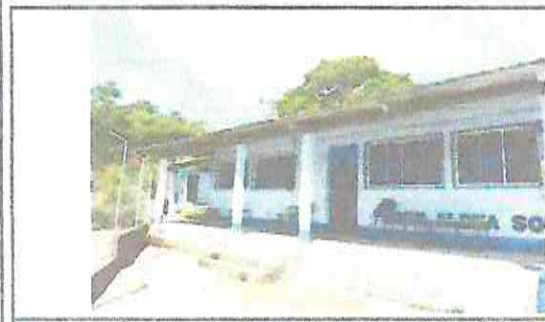
Foto 5: Sustitución de canal de metal, fabricación e instalación, con sus bajantes (parte Frontal)
