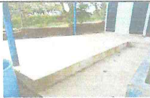
Foto 12: Instalación de piso cerámico en corredor en área de baños
