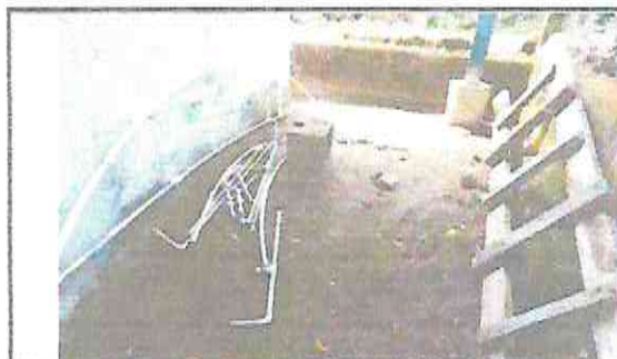
Foto 4: Sustitución de piso natural por torta de cemento
