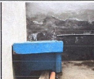
Foto 13 Sustrucción de pila de concreto por pila de Block (1.80mx1.10m)
