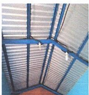
Foto1: Sustitución de lámina, por lámina troquelada aluzinc calibre 26'. Se realizará una ampliación de la cubierta ya que debido a fuertes lluvias ingresa el agua en las Aulas .
