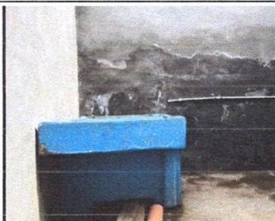
Foto 14 Sumistro e instalación de azulejo en pila de block (1.80mx1.10m)
