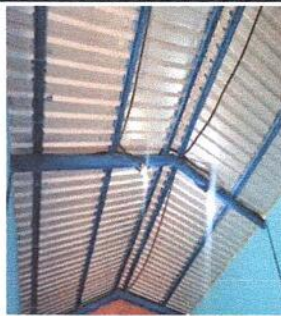
Foto 2: Sustitución de estructura de soporte de metal, por metal. Se realizará una ampliación de la estructura del techo ya que debido a fuertes lluvias ingresa el agua en las Aulas
