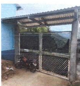
Foto 7: Sustrucción de Portón de metal (4.35mx3.00m)
