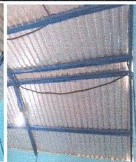
Foto 2: Sustitución de estructura de soporte de metal, por metal. Se realizará una ampliación de la estructura del techo ya que debido a fuertes lluvias ingresa el agua en las Aulas
