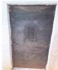
Foto 8: Mantenimiento a estructura (lijado, cambio de tubo, cepillado, sujeciones, aplicación de pintura) (0.90mx2.00m)
