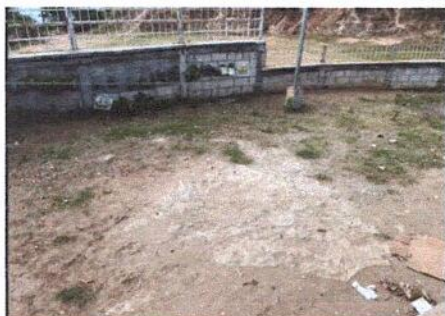
Foto 15 Reparación de planchas de concreto de patio (9.00x10.00m)
