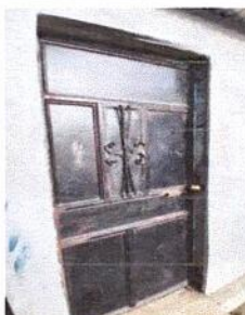
Foto 8: Mantenimiento a estructura (lijado, cambio de tubo, cepillado, sujeciones, aplicación de pintura) (0.90mx2.00m)
