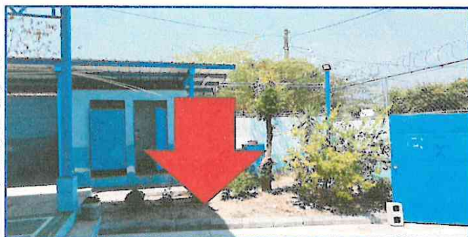
Foto 7: Esta área del patio es necesario colocar piso de concreto.
