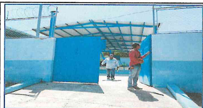
Foto 5: El portón del ingreso cuenta con columnas muy pequeñas y cada puerta del portón es muy pesada, por lo que no cierra de forma adecuada.
