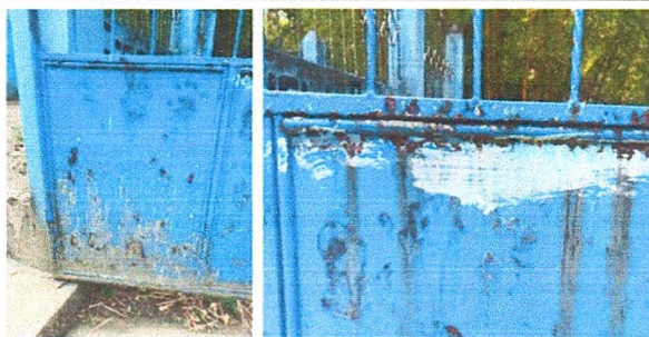
Foto 11: MANTENIMIENTO A PORTON DE METAL
