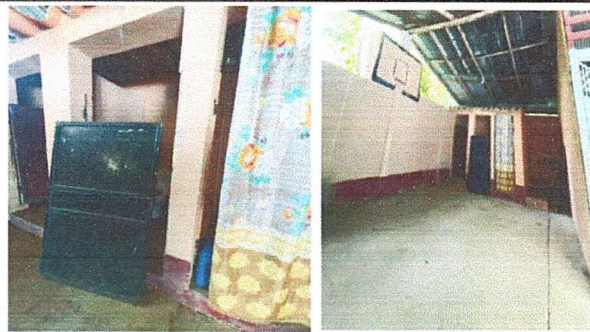
Foto 3: SUSTITUCIÓN DE PUERTA DE METAL A PUERTA PVC / PINTURA EN MUROS INTERIORES Y EXTERIORES DE BAÑOS
