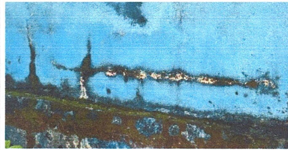
Foto 2: REPELLO Y CERNIDO EN AULA / PINTURA EN MUROS INTERIORES Y EXTERIORES DE AULA
