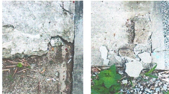
Foto 8: REPARACIÓN DE PLANCHA DE CONCRETO DE PATIO
