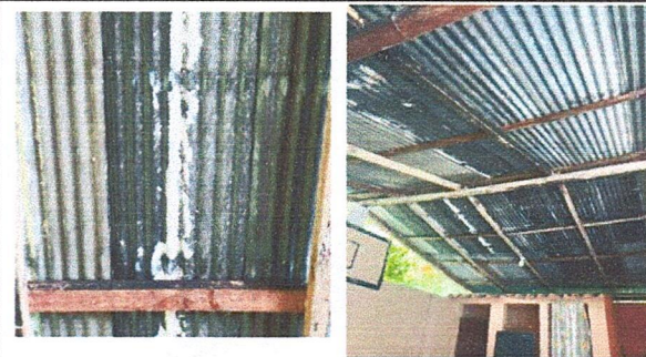
Foto 6: SUSTITUCIÓN DE LÁMINA, POR LÁMINA TROQUELADA ALUZINC CALIBRE 26 / SUSTITUCIÓN DE CAPOTE DE LÁMINA PARA LÁMINA TROQUELADA / SUSTITUCIÓN DE ESTRUCTURA DE SOPORTE DE METAL, POR METAL
