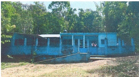
Foto 10: PINTURA EN MUROS EXTERIORES DE MURO PERIMETRAL
