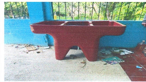
Foto 4: SUSTITUCIÓN DE PILA PLÁSTICA A PILA DE CEMENTO / INSTALACIÓN DE AZULEJO EN PILA
