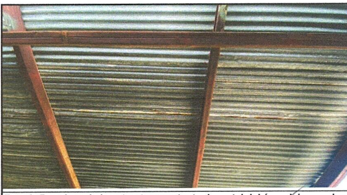
Foto 6: Deterioro de la estructura portante de metal del área del comedor escolar.
