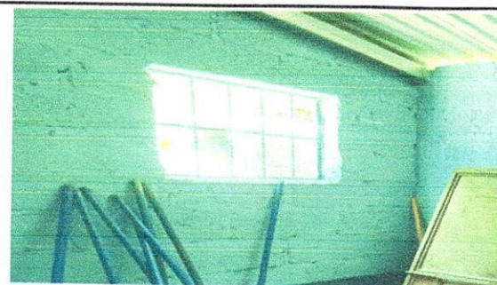
Foto 4: SUSTITUCIÓN DE VENTANA DE METAL A VENTANA DE PVC
