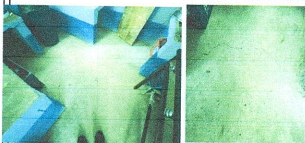
Foto 1: SUSTITUCIÓN DE PISO DE CEMENTO A PISO CERÁMICO
