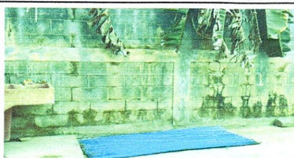
Foto 8: APLICACIÓN DE PINTURA EN MUROS EXTERIORES E INTERES (PINTURA IMPERMEABLE)
