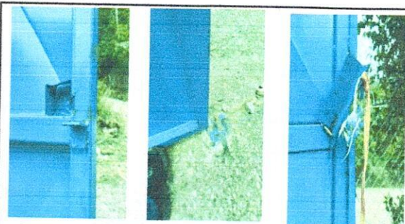
Foto 6: MANTENIMIENTO AL PORTON DE METAL Y CAMBIO DE CHAPA
