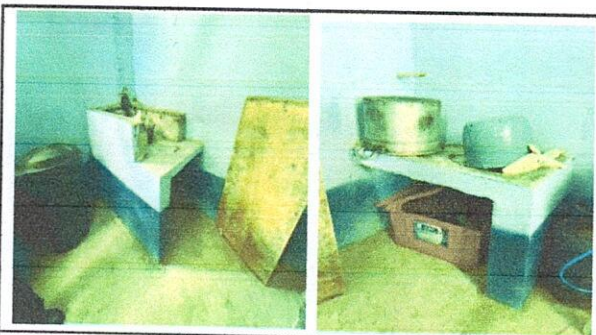
Foto 3: SUSTITUCIÓN DE LAVATRASTOS DE CEMENTO
