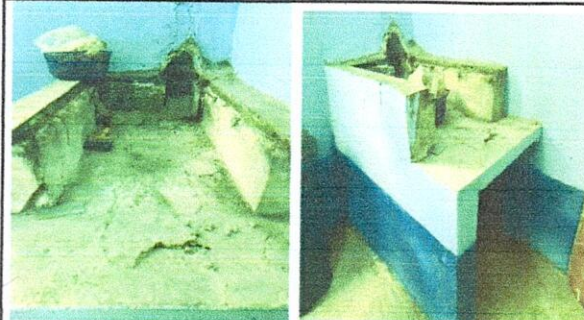
Foto 2: SUSTITUCIÓN DE ESTUFA DE BLOCK POR COCINA DE LADRILLO TAYUYO / SUMINISTRO E INSTALACIÓN DE CHIMENEA / PLANCHA DE ESTUFA DE COCINA
