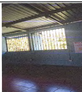
Foto 2: Instalación de Ventanas PVC en Aulas
