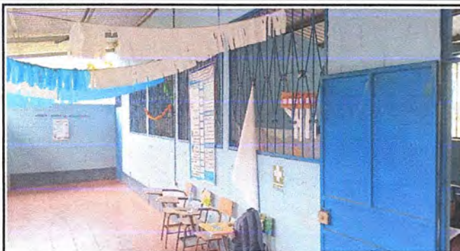
Foto 1: Instalación de Ventanas PVC en Aulas
