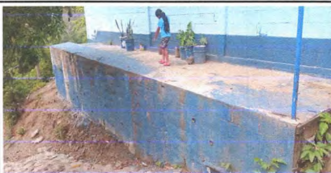
Foto 11: Instalación de Baranda en Área de Peligro en Corredor
