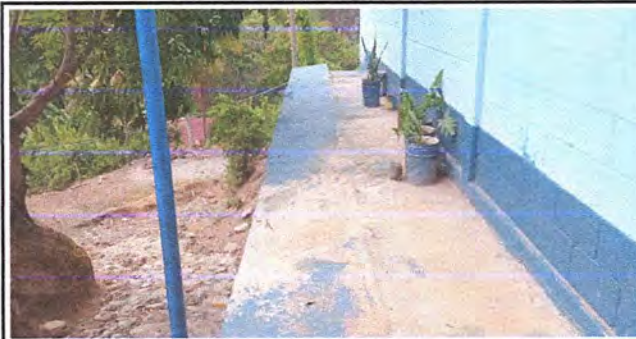
Foto 12: Instalación de Baranda en Área de Peligro en Corredor
