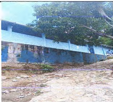
Foto 9: Pintura en Muros Exteriores e Interiores en Corredor
