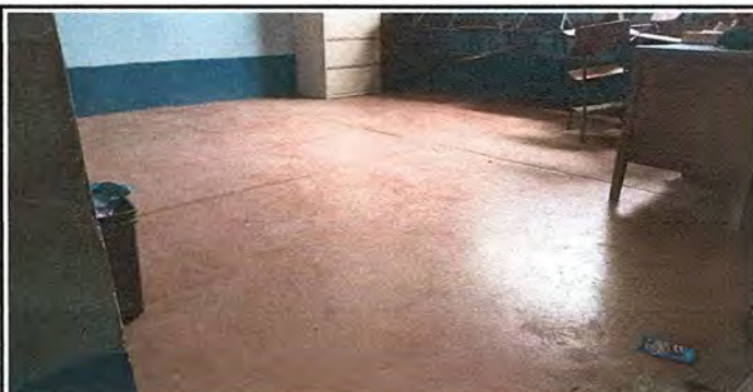
Foto 5: Instalación de Piso Cerámico en Aulas
