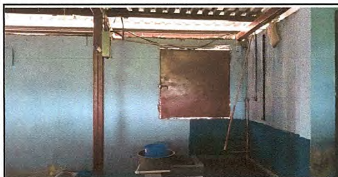
Foto 17: Demolición, Sustitución de Ventana de Metal e Instalación de Balcón de Metal en Muro Perimetral (Se Pretende Darle Ampliación a la Ventana para Mejor Ventilación)
