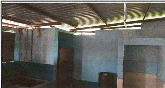
Foto 13: Instalación de Tubería PVC en Baños
