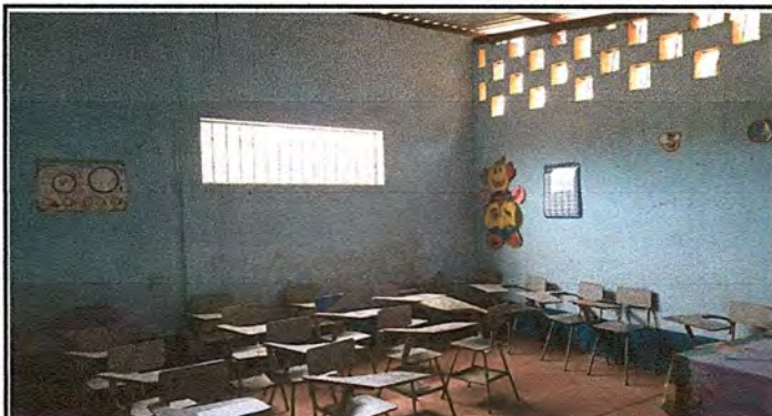
Foto 7: Pintura en Muros de Aulas
