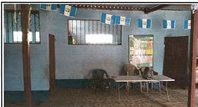
Foto 9: Pintura en Muros de Aulas
