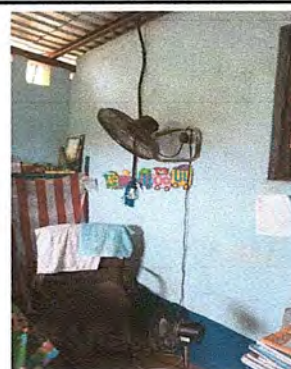
Foto 10: Sustitución de Ventiladores de Pared en Aulas
