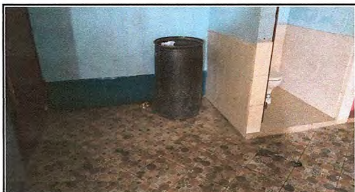
Foto 15: Área para Instalación de Lavamanos de Block en Baños
