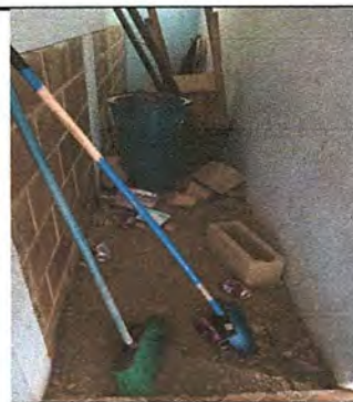
Foto 18: Instalación de Planchas de Concreto en Patio
