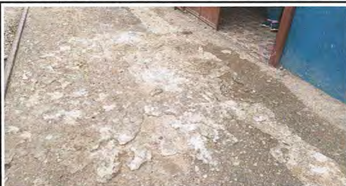
Foto 19: Sustitución de Planchas de Concreto en Patio
