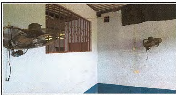
Foto 11: Sustitución de Ventiladores en Aulas
