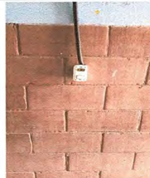
Foto 2: Sustitución de Sistema Eléctrico en Aulas
