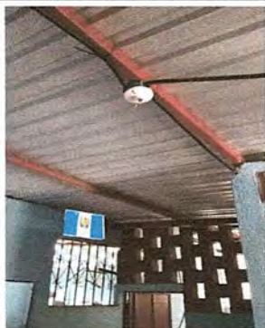
Foto 1: Sustitución de Sistema Eléctrico en Aulas
