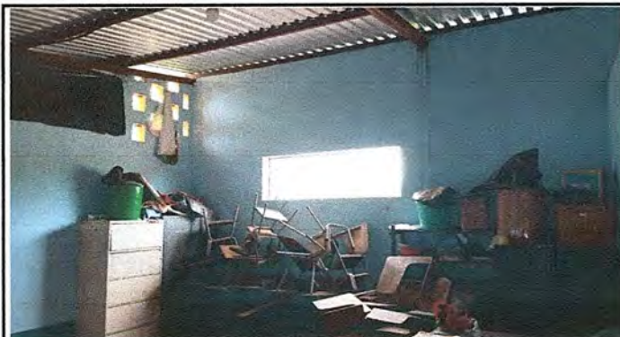
Foto 8: Pintura en Muros de Aulas
