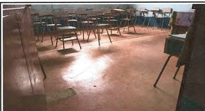
Foto 4: Instalación de Piso Cerámico Mate en Aulas
