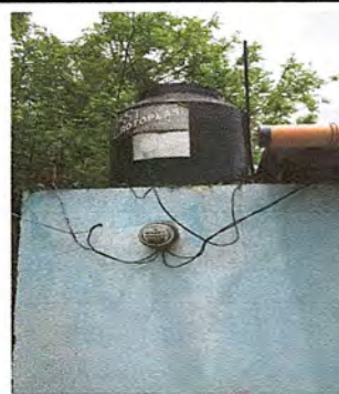
Foto 12: Sustitución de Cisterna en Baños
