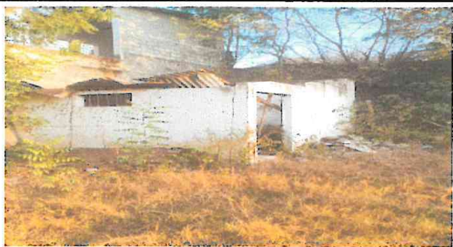
Foto1: cubierta de lámina y estructura de techo. Area de cocina
