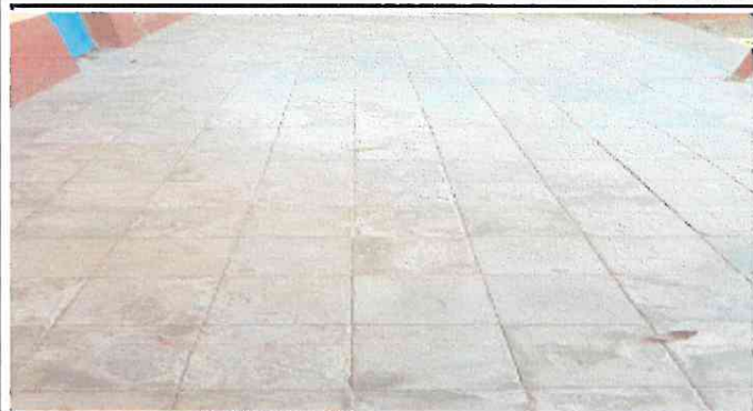
Foto7: sustitución de 99 M2 de piso por piso cerámico.
