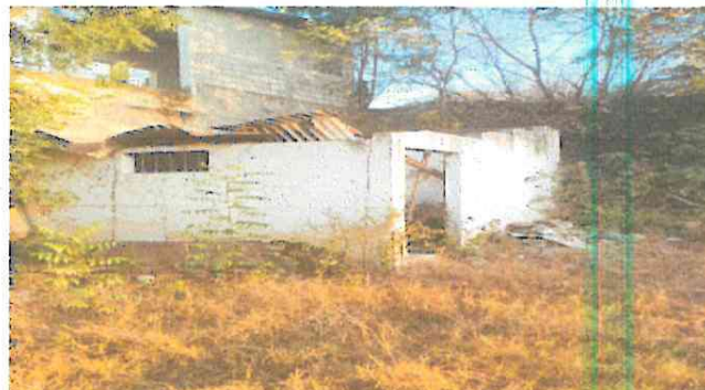
foto 2: Levantamiento de un metro y medio de bloques y repello; para una altura de 4 metros de alto de paredes.
