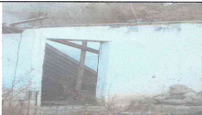
Foto 3: sustitución y fabricación de puerta de metal. 2 m de ancho por 1 metro de alto
