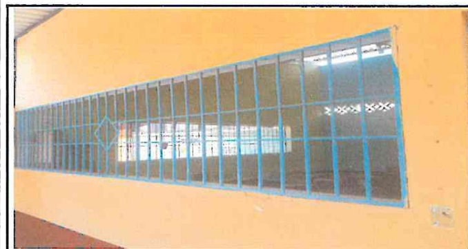
foto 9: sustitución por ventana de pvc con vidrio 4.10 M ancho por 0.90 m. alto
