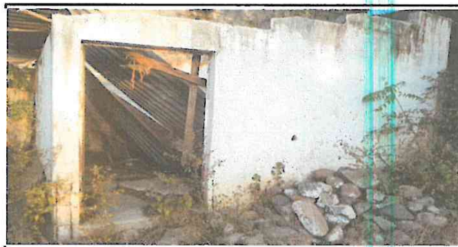
foto 6. sustitución de piso de granito.
