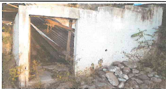
Foto 5: sustitución de piso de torta de cemento
