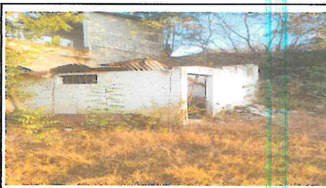
Foto 4: sustitución de ventana por ventana de metal de 2.5 metros de ancho por 1.5 metros de alto
