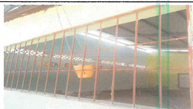
foto 8: sustitución por ventana de pvc con vidrio 4.10 M ancho por 0.90 m. alto
