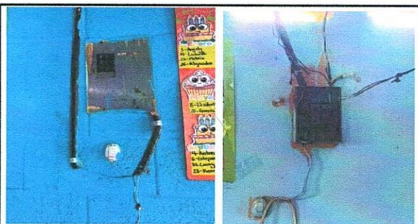
Foto 17: CAJA GENERAL ELECTRIC 4 POLOS (TABLERO MONOFASICO) / CAJA GENERAL ELECTRIC 2 POLOS (TABLERO MONOFASICO)
