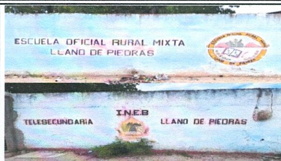
Foto 14: ROTULACIÓN Y ESCUDO EN MURO PERIMETRAL. (PRIMARIA E INEB TS), (MATERIALES Y MANO DE OBRA)
