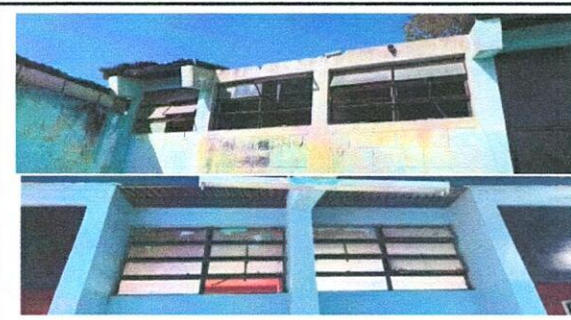
Foto 4: SUSTITUCIÓN DE VENTANAS DE METAL A VENTANA PVC EN BAÑOS
