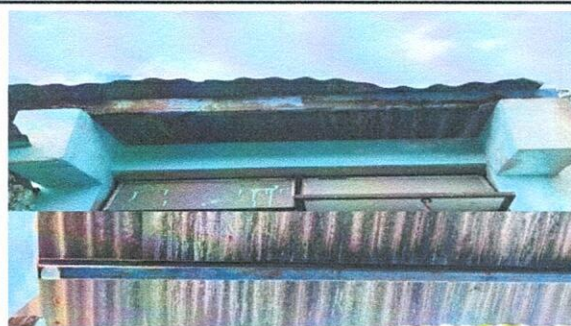
Foto 2: MANTENIMIENTO A ESTRUCTURA DE SOPORTE DE METAL (LIJADO Y APLICACIÓN DE PINTURA)
