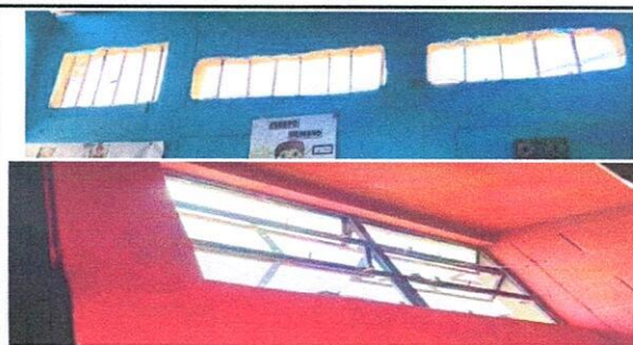
Foto 5: SUSTITUCIÓN DE VENTANAS DE METAL A VENTANA PVC EN AULAS
