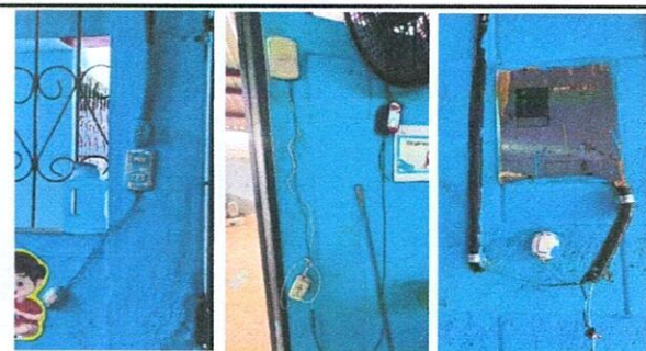
Foto 21: SE SUSTITUIRÁ CABLEADO, SWITCH, FLEXITUBO, FLIPONES, Y SE REALIZARÁ LA CONEXIÓN ADECUADA.
