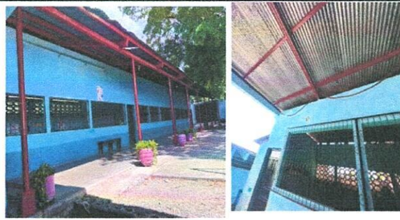
Foto 20: SE SUSTITUIRA EL CABLEADO DE DOS PASILLOS INCLUYENDO FLEXITUBO
