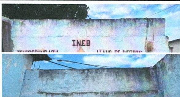
Foto 9: REPARACIÓN DE VIGA SUPERIOR DE MURO PERIMETRAL (MARQUESINA) Al momento que se realizó la cancha la hicieron los alumnos por tal motivo quedo rustico el cemento, lo cual no es comodo para llevar a cabo las diferentes actividades de ejercicios.
