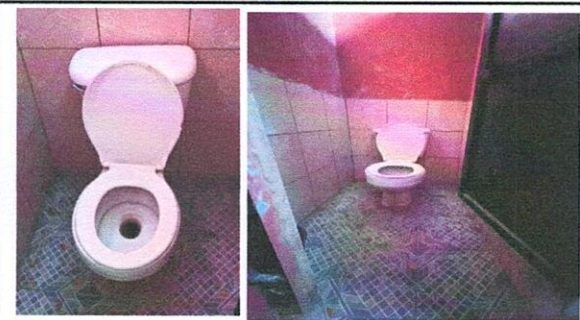
Foto 3: SUSTITUCIÓN DE INODORO E INSTALACIÓN DE INODORO CON ACCESORIOS
