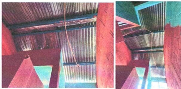
Foto1: SUSTITUCIÓN DE LÁMINA, POR LÁMINA TROQUELADA ALUZINC CALIBRE 26 (INCLUYE MANO DE OBRA) / SUSTITUCIÓN DE CAPOTE DE LÁMINA PARA LÁMINA TROQUELADA
