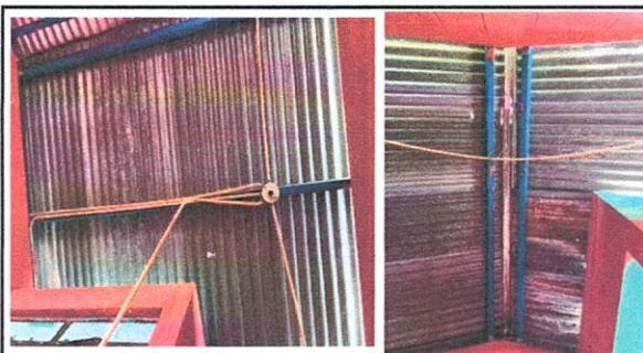
Foto 22: SE CAMBIARÁ TODO EL CABLEADO, TUBO DUCTO, LAMPARAS, PLAFONERAS, Y CIRCUITOS DE LOS BAÑOS YA QUE LOS ACTUALES CABLES SE ENCUENTRAN TIESOS Y DETERIORADOS.
