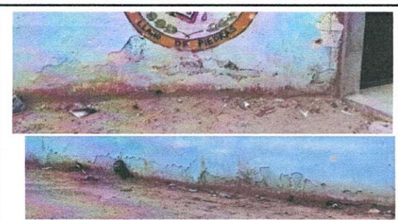
Foto 6: REPELLO Y CERNIDO EN MURO PERIMETRAL EXTERIOR
