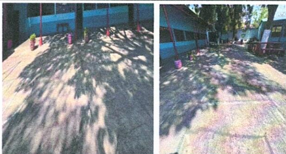
Foto 11: CERNIDO FINO EN CANCHA DEPORTIVA (Al momento que se realizó la cancha la hicieron los alumnos por tal motivo quedo rustico el cemento, lo cual no es comodo para llevar a cabo las diferentes actividades de ejercicios.)
