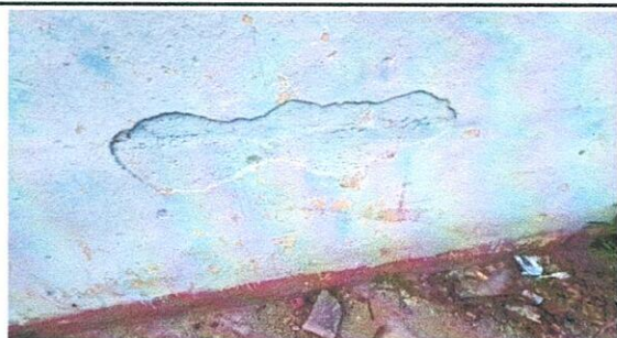
Foto 7: REPELLO Y CERNIDO EN MURO PERIMETRAL EXTERIOR
