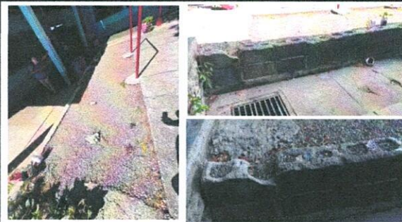
Foto 12: REPARACIÓN DE LOSA DE CONCRETO DE PATIO A UN COSTADO DE LA CANCHA)
