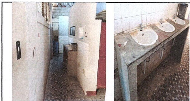
Foto 5: Servicios Sanitarios varones, módulo 1, cambio de llaves de lavamanos, pintura e iluminadad.
