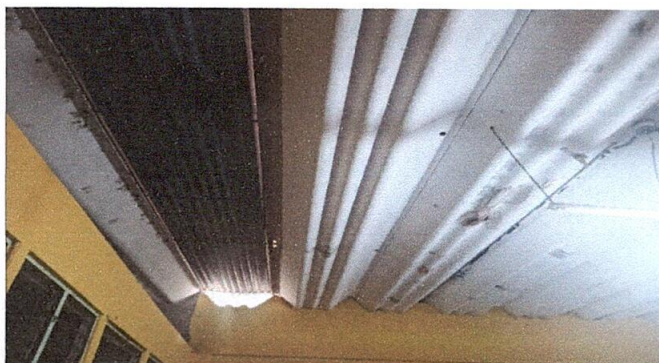
Foto 3: Aula modulo 1, sustitución de estructura techo duralita por lámina.
