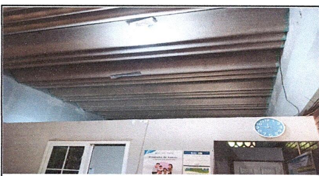
Foto 4: Dirección modulo 1, sustitución de estructura techo duralita por lámina.
