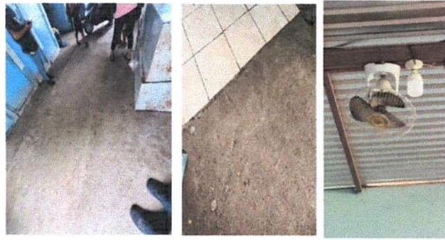
Foto 10: SUSTITUCIÓN DE PISO DE CEMENTO A PISO CERÁMICO (ANTIDESLIZANTE) EN CORREDOR Y SUSTITUCIÓN DE VENTILADOR
