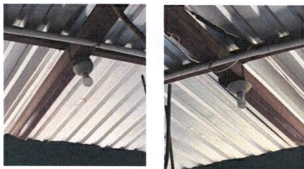
Foto 9: SUSTITUCIÓN DE LAMPARAS LED / SUSTITUCIÓN DE PLAFONERAS / SUSTITUCIÓN CABLEADO ELÉCTRICO CALIBRE 12 / INSTALACIÓN DE FLEXITUBO
