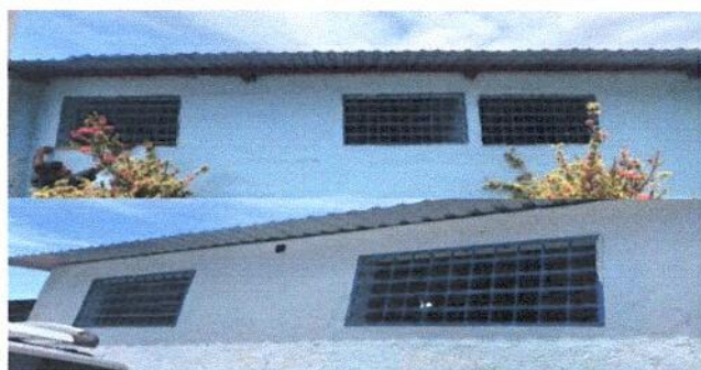
Foto7: SUSTITUCIÓN DE BALCON DE METAL A VENTANA PVC (MEDIDAS 1.35 LARGO / 0.75 ALTO)
