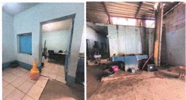
Foto 1: SUMINISTRO E INSTALACIÓN PUERTA DE METAL (MEDIDAS= 1.00 MT ANCHO * 2.10 MTS ALTO) / SUSTITUCIÓN DE PILA POR TANQUE DE AGUA CON 1 LAVADERO (MEDIDAS 1.10 LARGO, 0.90 ALTO, 0.90 ANCHO)
