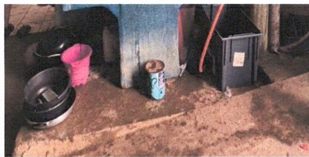
Foto 6: SUSTITUCIÓN DE PISO DE CEMENTO A PISO CERAMICO EN COCINA
