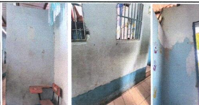
Foto 11: APLICACIÓN DE PINTURA EN MUROS INTERIORES
