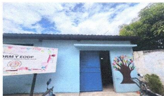
Foto 12: INSTALACIÓN DE CANAL DE METAL
