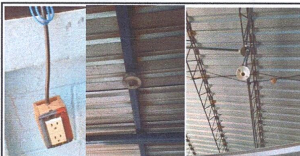
Foto 5: REPARACIÓN DE SISTEMA ELÉCTRICO, LÁMPARAS, PLAFONES, APAGADORES, TOMACORRIENTES, CABLEADO Y TUBO DUCTO.
