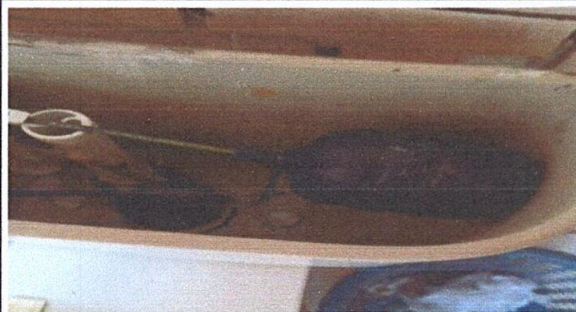
Foto 2: SUSTITUCIÓN DE ACCESORIOS PARA BAÑOS
