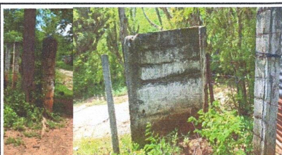
Foto 6: SUSTITUCIÓN DE MURO PERIMETRAL DE MADERA A MURO PERIMETRAL DE MALLA Y POSTES DE METAL FUNDIDOS.
