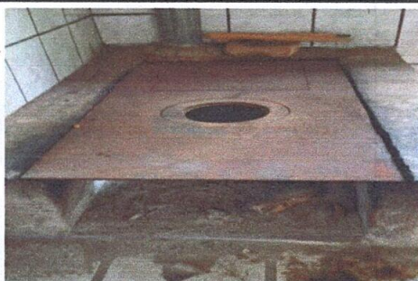
Foto 3: SUSTITUCIÓN DE PLANCHA DE ESTUFA RURAL
