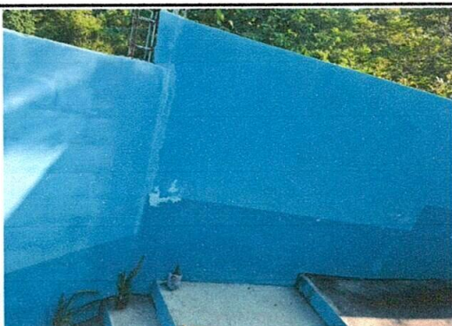
Foto 3: Pintura en muros exterior e interior
