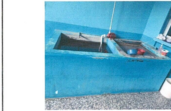
Foto 2: Sustitución de pila de dos lavaderos
