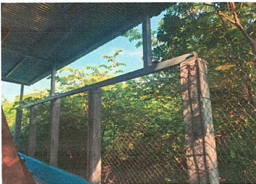
Foto 3: Reparación de muro perimetral de block con tubo HG y malla galvanizada (cambiar malla por block, deterioro de malla y tubo HG)
