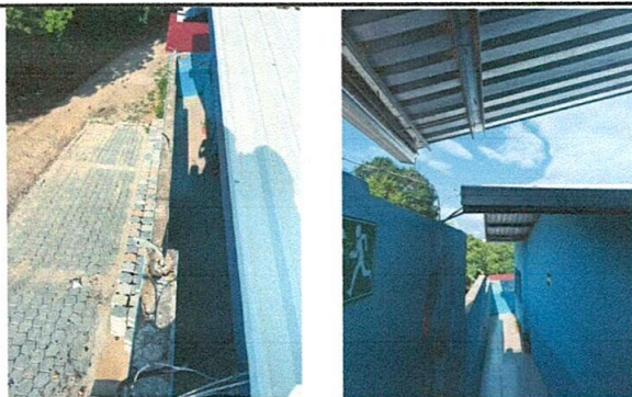
Foto 5: Instalación de estructura portante de metal, filtración de agua de lluvia en corredor (extensión en patio)
