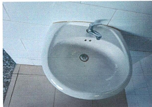
Foto 6: Sustrucción de grifos
