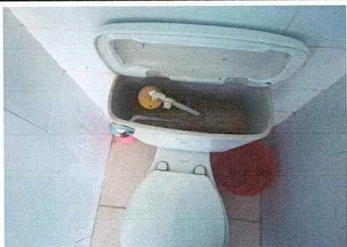
Foto 5: Sustrucción de inodoro
