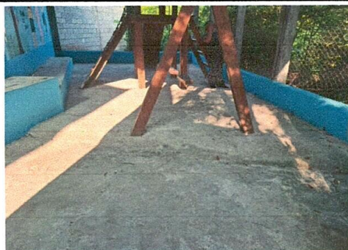
Foto 2: Sustrucción de piso de torta de concreto (por piso de torta pulido, área de juegos)
