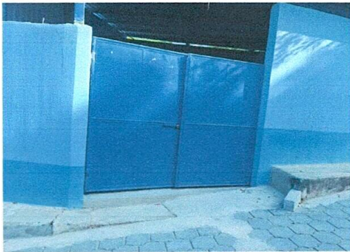
Foto 1: Mantenimiento a porton de metal (lijado y pintura)
