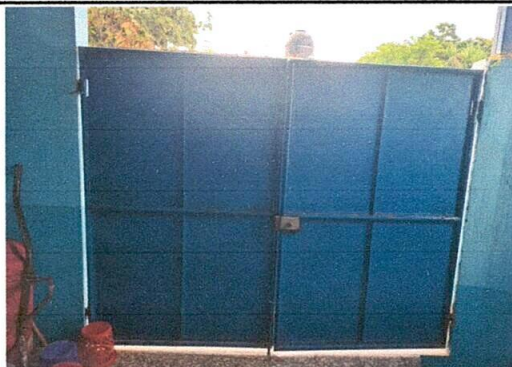
Foto 1: Sustrucción de chapa de la puerta principal
