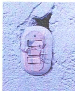
Foto7: SUSTITUCIÓN DE STICHW TRIPLE - SUSTITUCIÓN DE TOMACORRIENTES DOBLES
