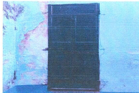
Foto 4: SUMINISTRO E INSTALACIÓN DE PUERTA DE METAL
