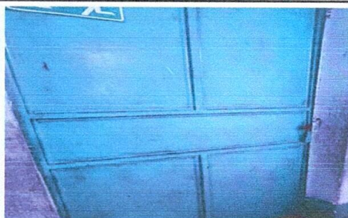
Foto 11: MANTENIMIENTO A PUERTAS DE METAL DE AULAS
