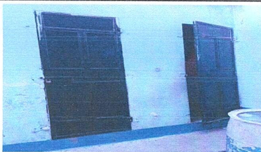
Foto 5: MANTENIMIENTO A PUERTAS DE METAL
