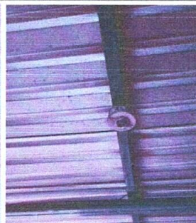
Foto 8: SUSTITUCIÓN DE LAMPARAS CON PLAFONERAS - SUSTITUCIÓN DE CABLEADO ELÉCTRICO INCLUYE FLEXITUBO
