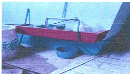
Foto 3: SUSTITUCIÓN DE LAVAMANOS DE CEMENTO POR PILA PLÁSTICA
