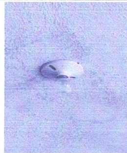
Foto 8: SUSTITUCIÓN DE LAMPARAS CON PLAFONERAS - SUSTITUCIÓN DE CABLEADO ELÉCTRICO INCLUYE FLEXITUBO
